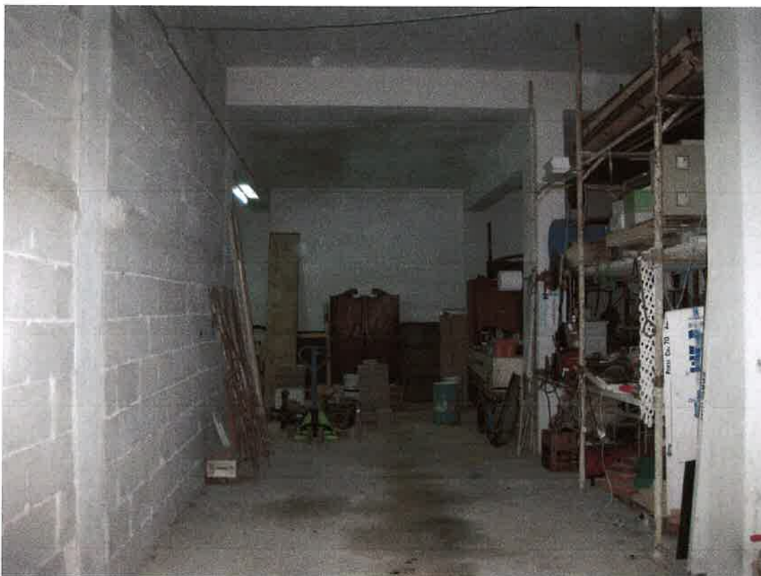
Foto 51: il locale box identificato, nel foglio 7 di Bagheria, dalla particella 1642 sub. 41; in difformità a quanto rappresentato catastalmente, manca la muratura di separazione dal limitrofo locale identificato dalla particella 1642 sub. 40
