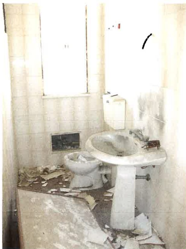
Foto 29: il w.c. a servizio dell'unità immobiliare
