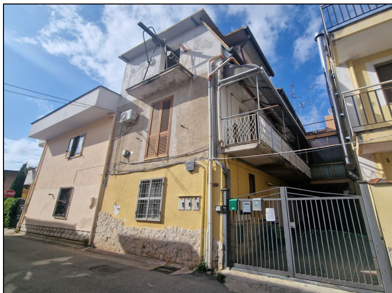
Foto 2: vista del Fabbricato di ricaduta P.lla 398, in corrispondenza del civ. 12 di Via Pisano.
