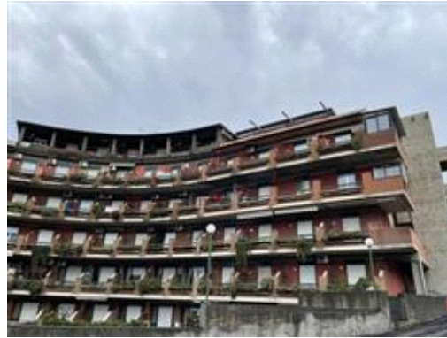
Vista del fabbricato ala Etna
