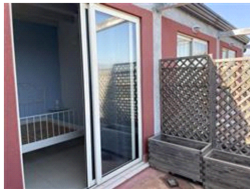
Vano annesso, realizzato sulla terrazza adiacente
