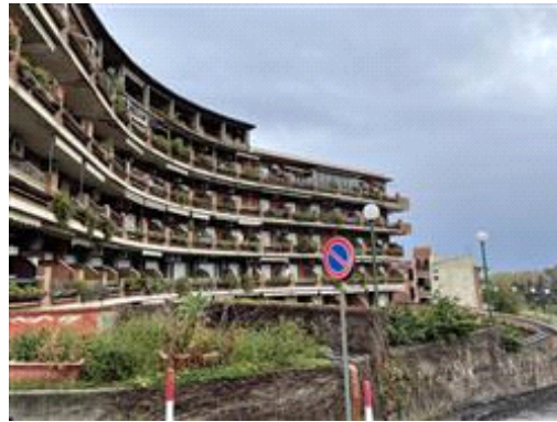
Vista del fabbricato ala Alcantara
