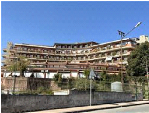
Vista del fabbricato fronte mare
