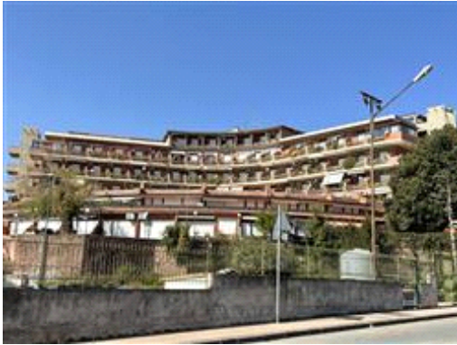
Vista del fabbricato fronte mare
