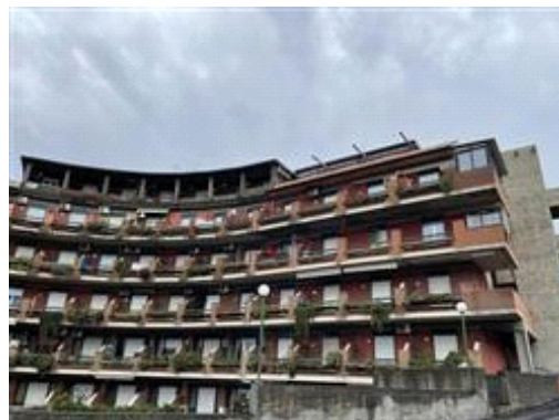
Vista del fabbricato ala Etna
