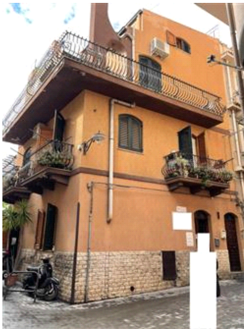
Vista del fabbricato (angolo Via Silipigni e Via Vecchio Macello)
