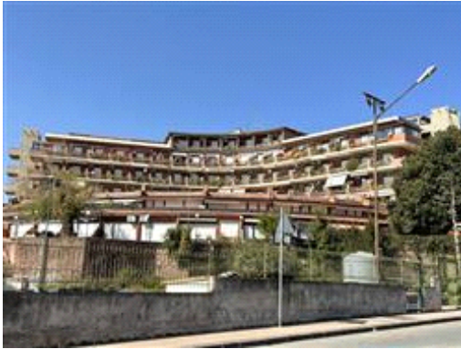
Vista del fabbricato fronte mare
