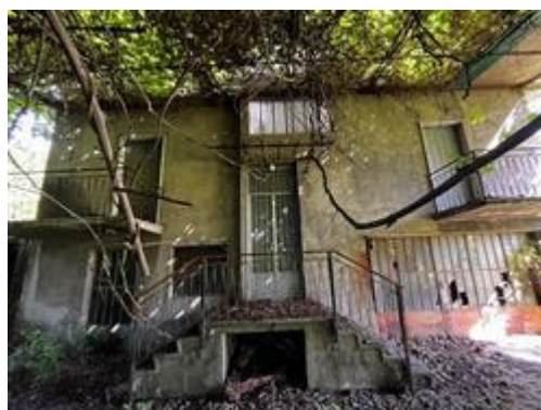
Il fronte dell'edificio sottostante al portico
