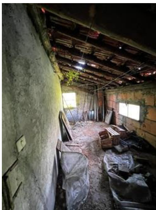
Porzione di sottotetto al piano secondo
