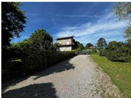
L'immobile visto a lato della Via Prealpi
