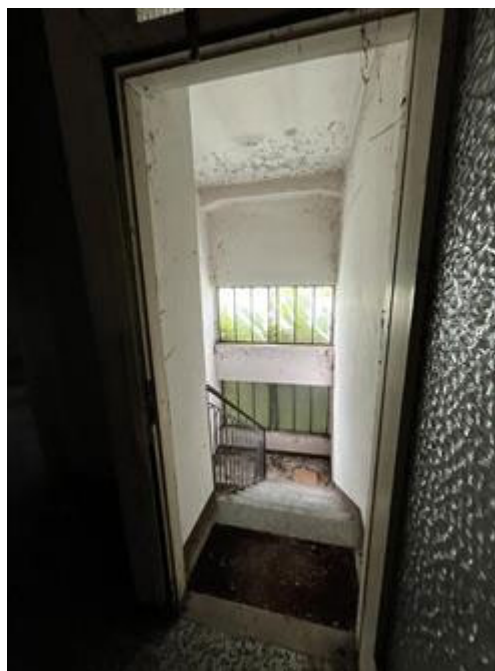
La scala di collegamento interna
