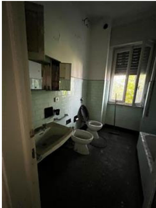
Bagno al piano primo
