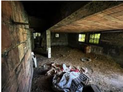
La rimessa per mezzi agricoli al piano terra
