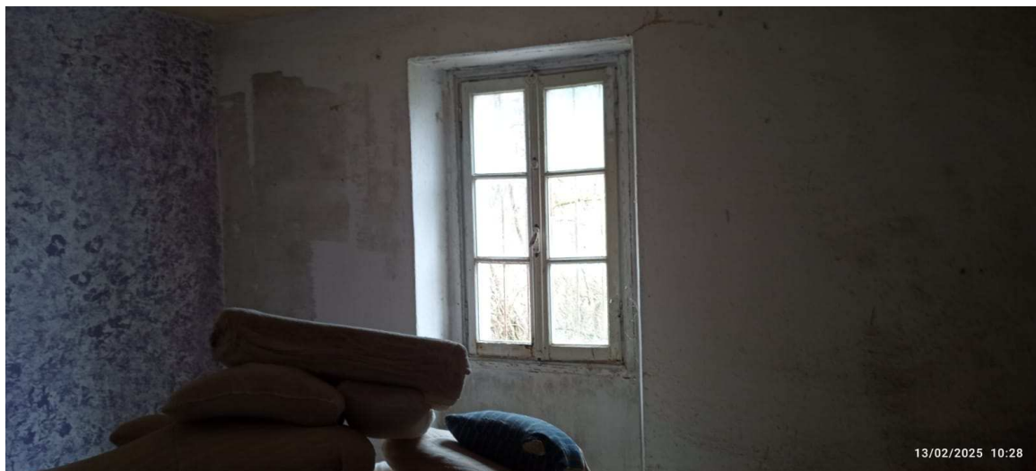
Interno – locale uso cucina
