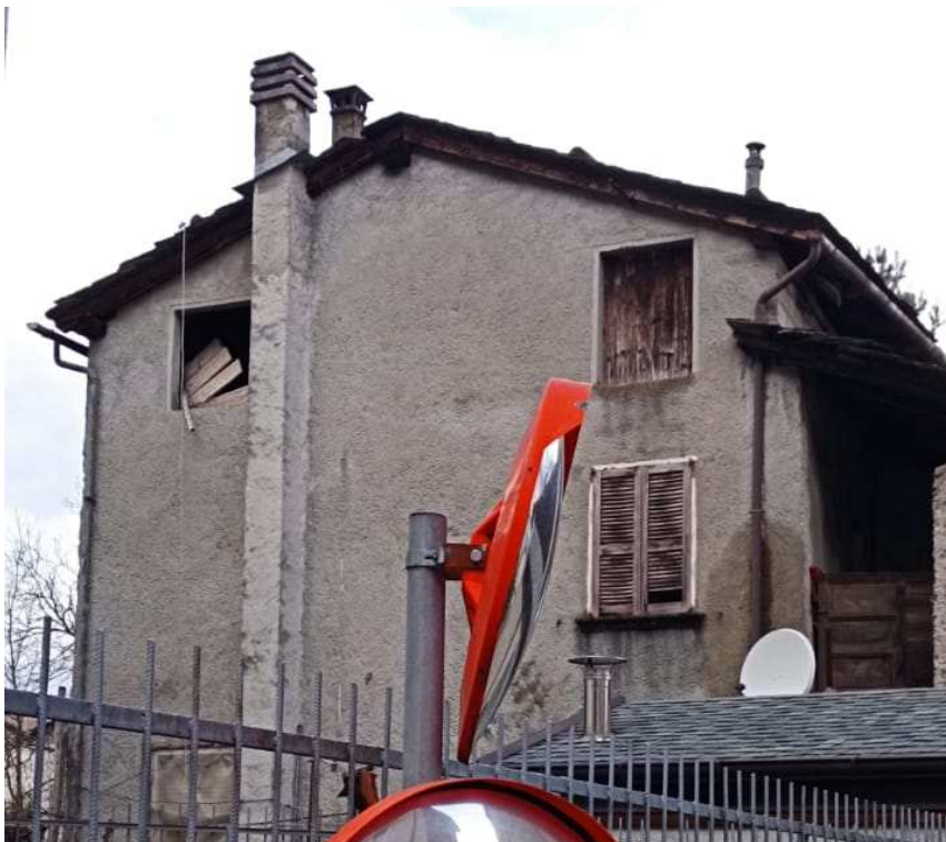
Esterno Lato Sud
