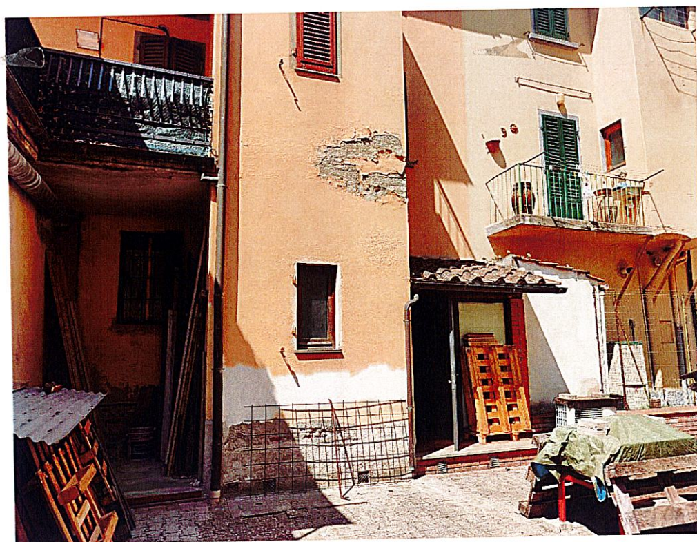
Foto 15 - Il resede con la piccola loggia sulla sinistra
