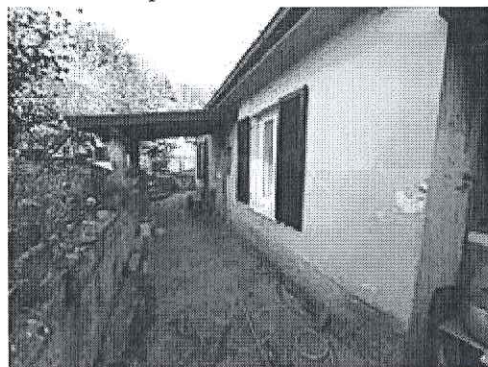
Esterno piano terra
