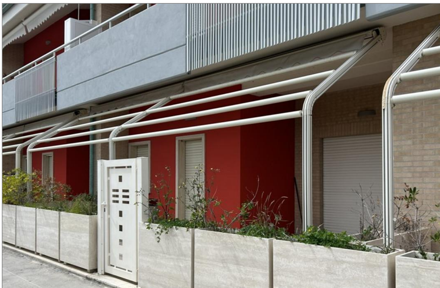
P.la 1734 sub.5: corte/esterno
