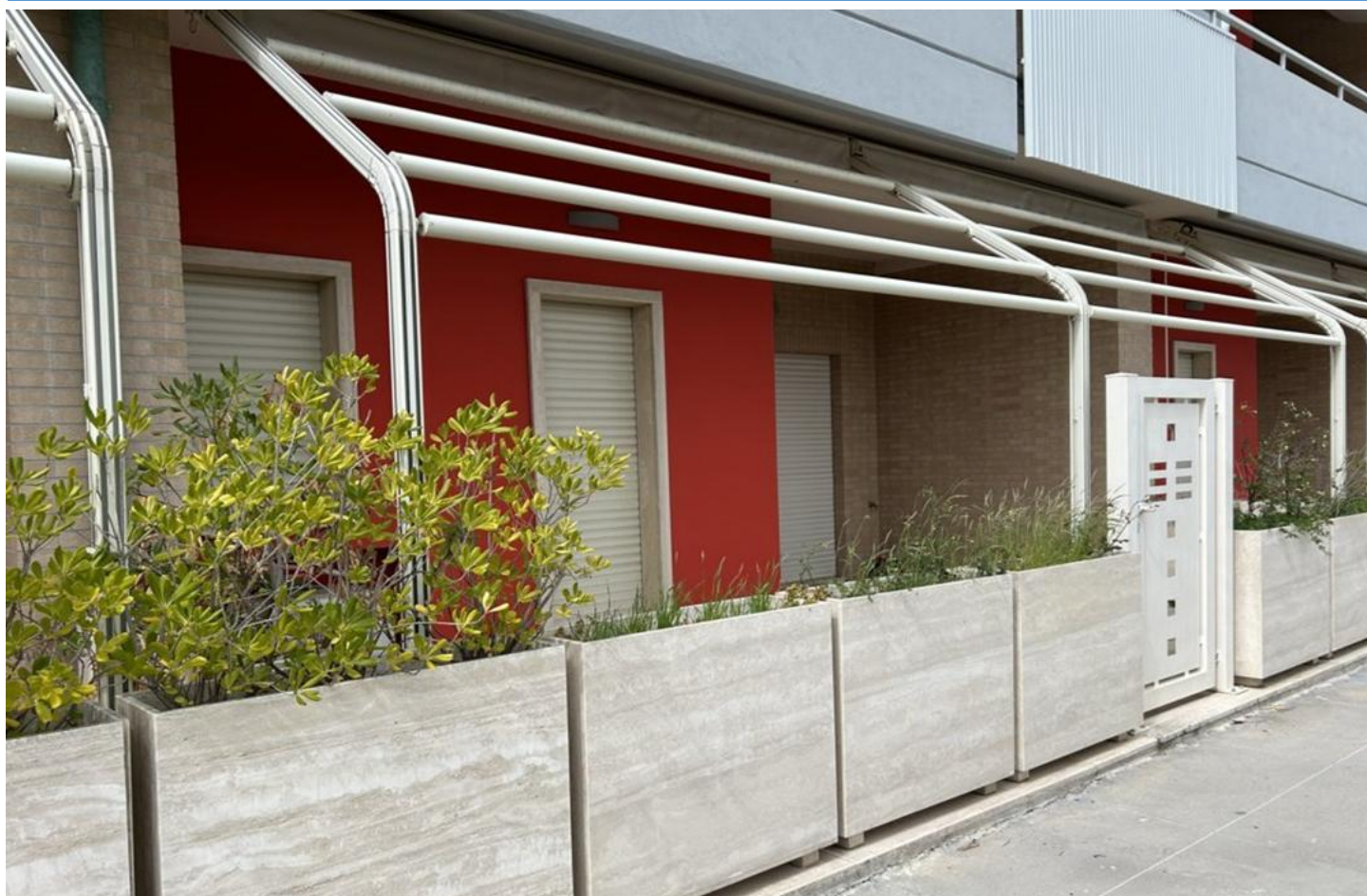
P.la 1734 sub.5: corte/esterno
