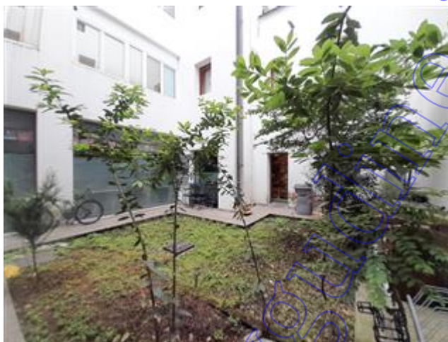
corte interna condominiale - sub. 3 B.C.N.C.
