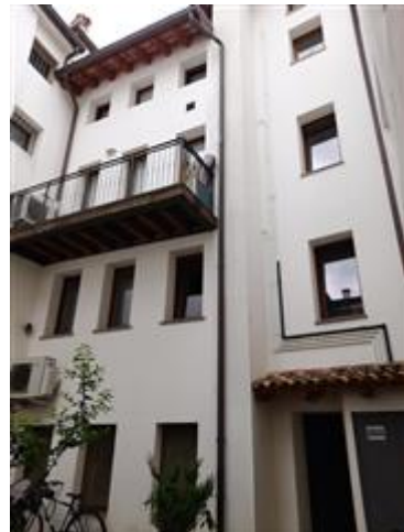
Facciata interna con accesso alla corte
