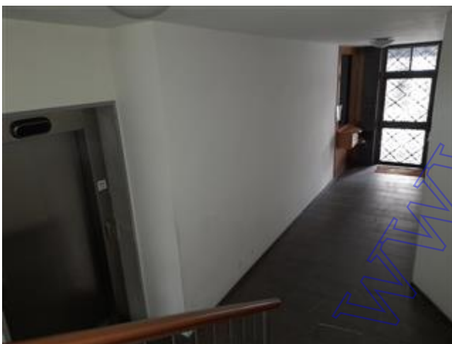
Atrio condominiale sub. 3 - B.C.N.C.
