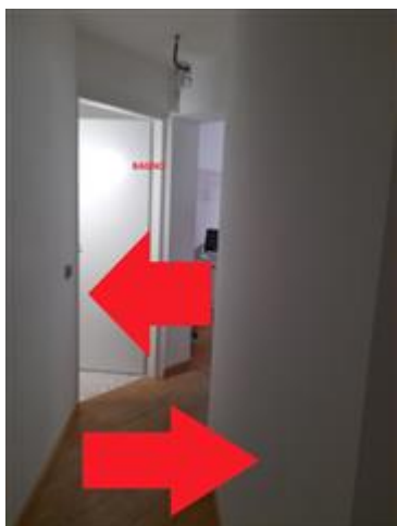
Bagno e corridoio difformi
