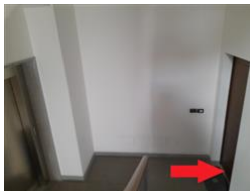
Ingresso all'appartamento dal pianerottolo - sub. 3 - B.C.N.C.
