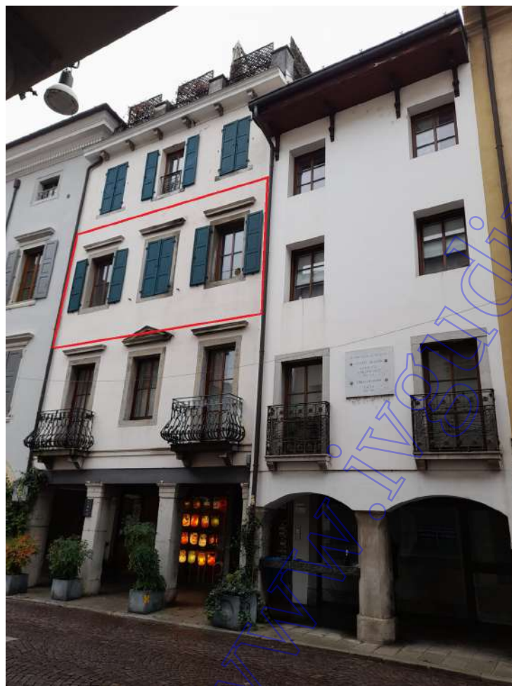
Facciata principale sulla via Vittorio Veneto ed ingresso al fabbricato
