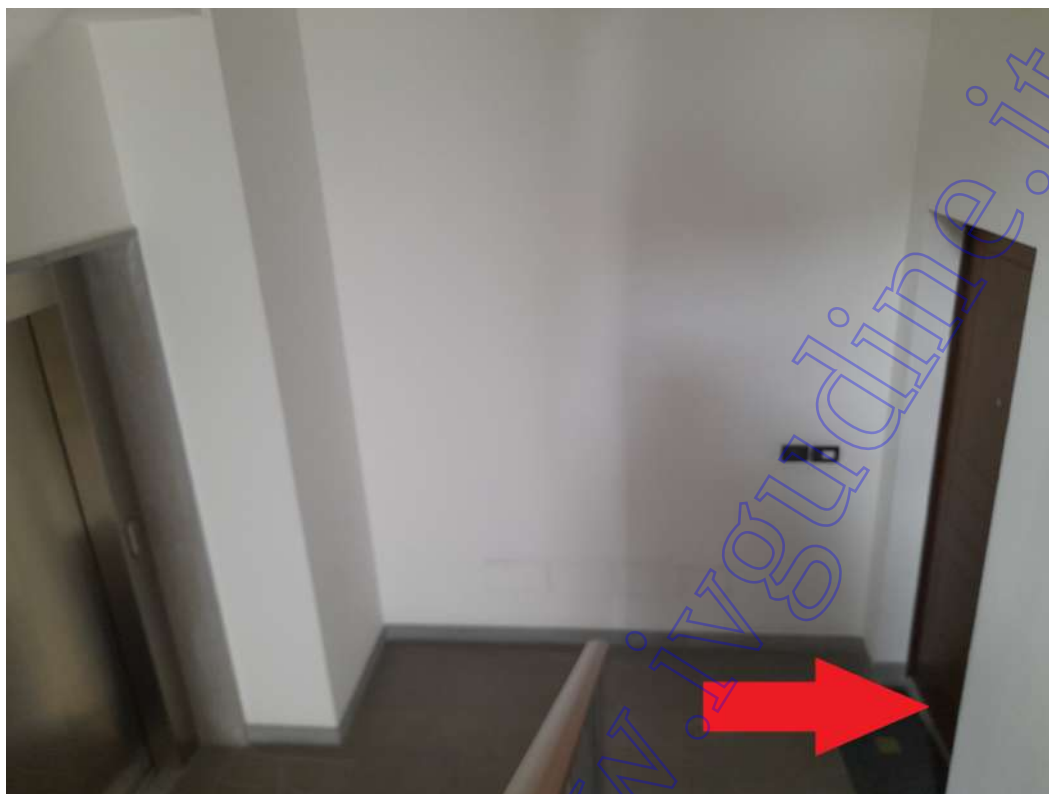
Ingresso all'appartamento dal pianerottolo - sub. 3 - B.C.N.C.
