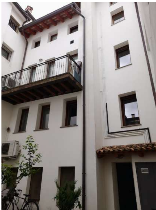
Facciata interna con accesso alla corte
