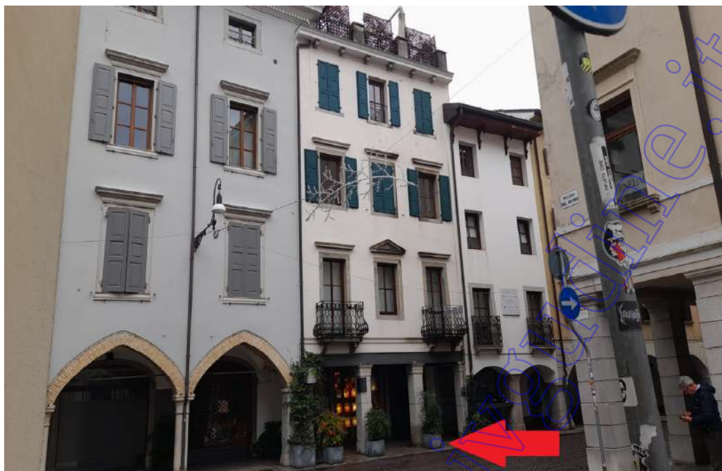
Fabbricato condominiale visto da incrocio tra via Vittorio Veneto e piazza del Duomo
