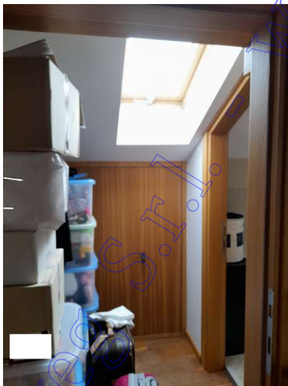
disimpegno al 4° piano originato dalla chiusura del sottotetto non abitabile con serramento
