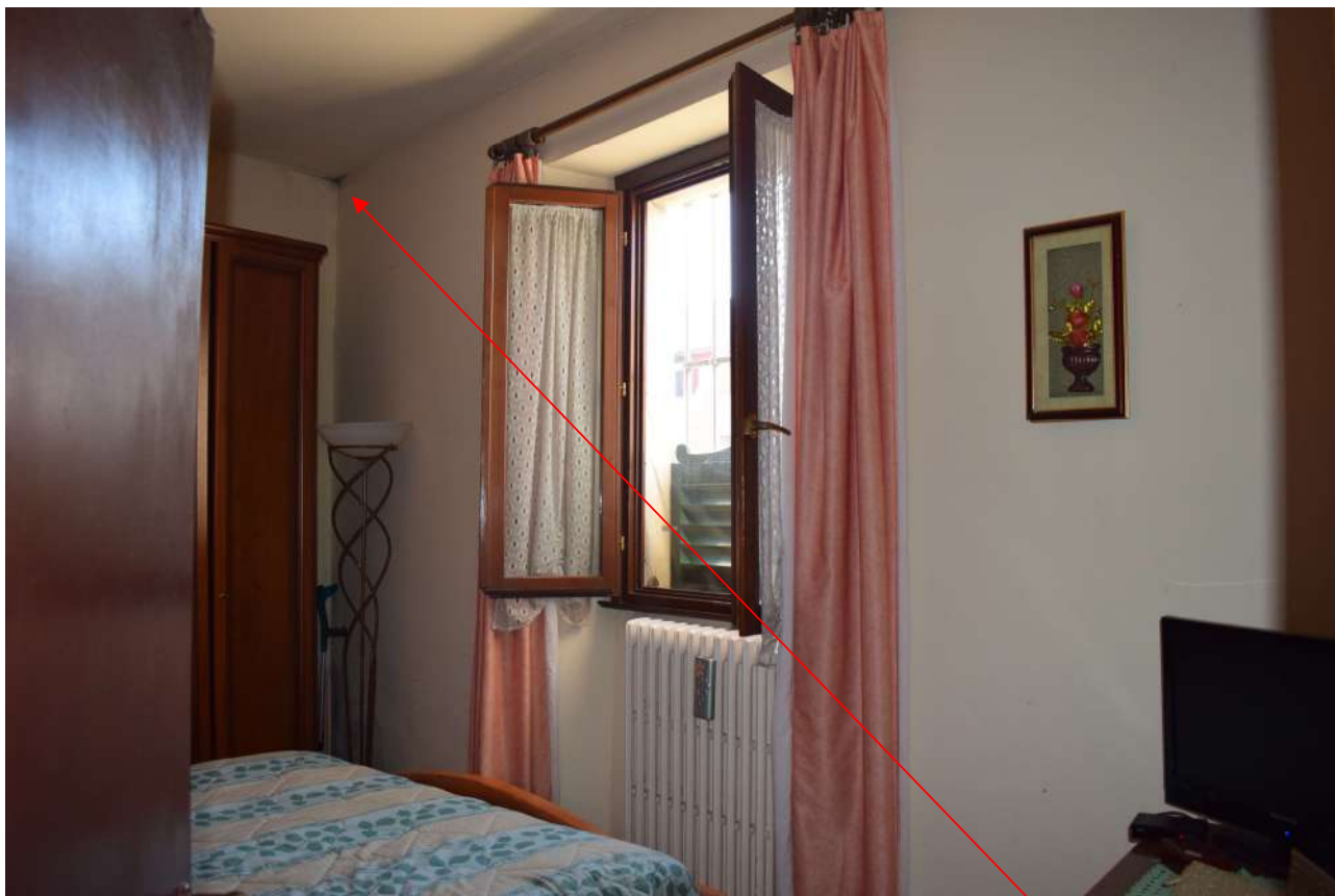
Foto n. 14 _ Sopralluogo del 13/02/2024 La camera doppia. Si notano tracce condensa e muffa nell'angolo
