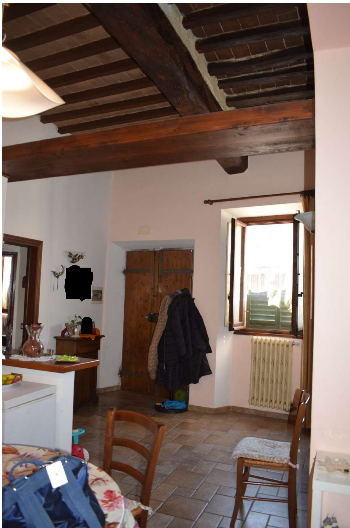
Foto n. 11 _ Sopralluogo del 13/02/2024 Appartamento piano terra. Ingresso/cucina/soggiorno. Si nota il soffitto ligneo con travi, travetti e pannelle in cotto
