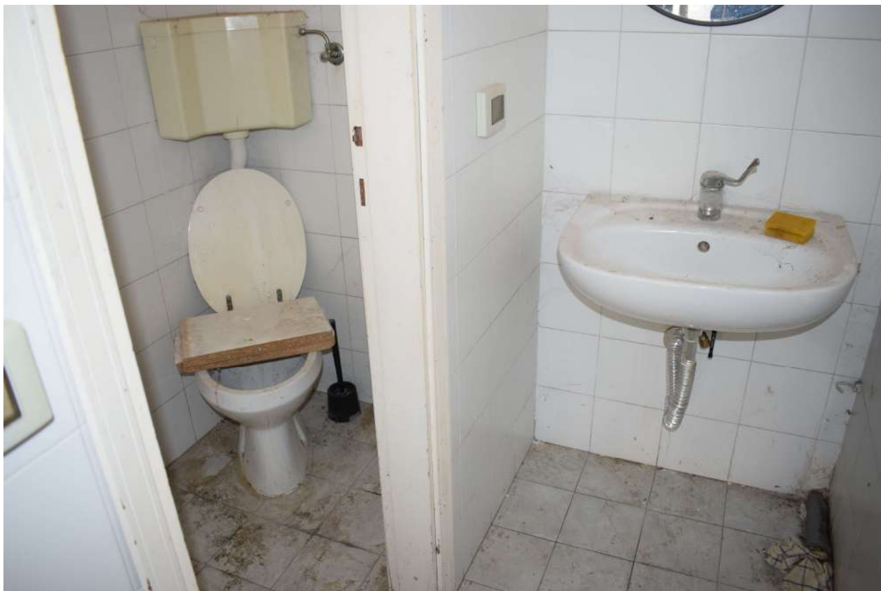
Foto n. 14 _ Sopralluogo del 13/02/2024 Antibagno e wc
