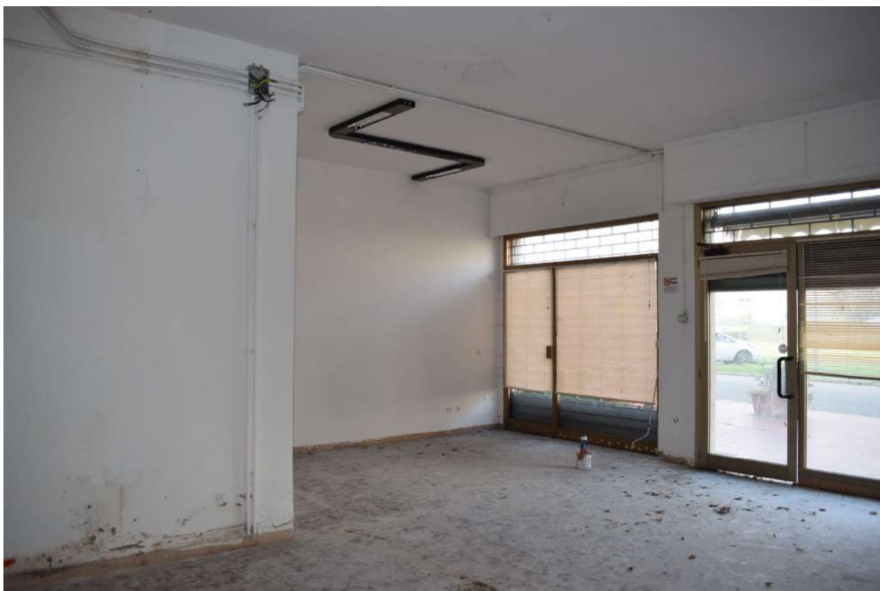
Foto n. 10 _ Sopralluogo del 13/02/2024 Il negozio - interni
