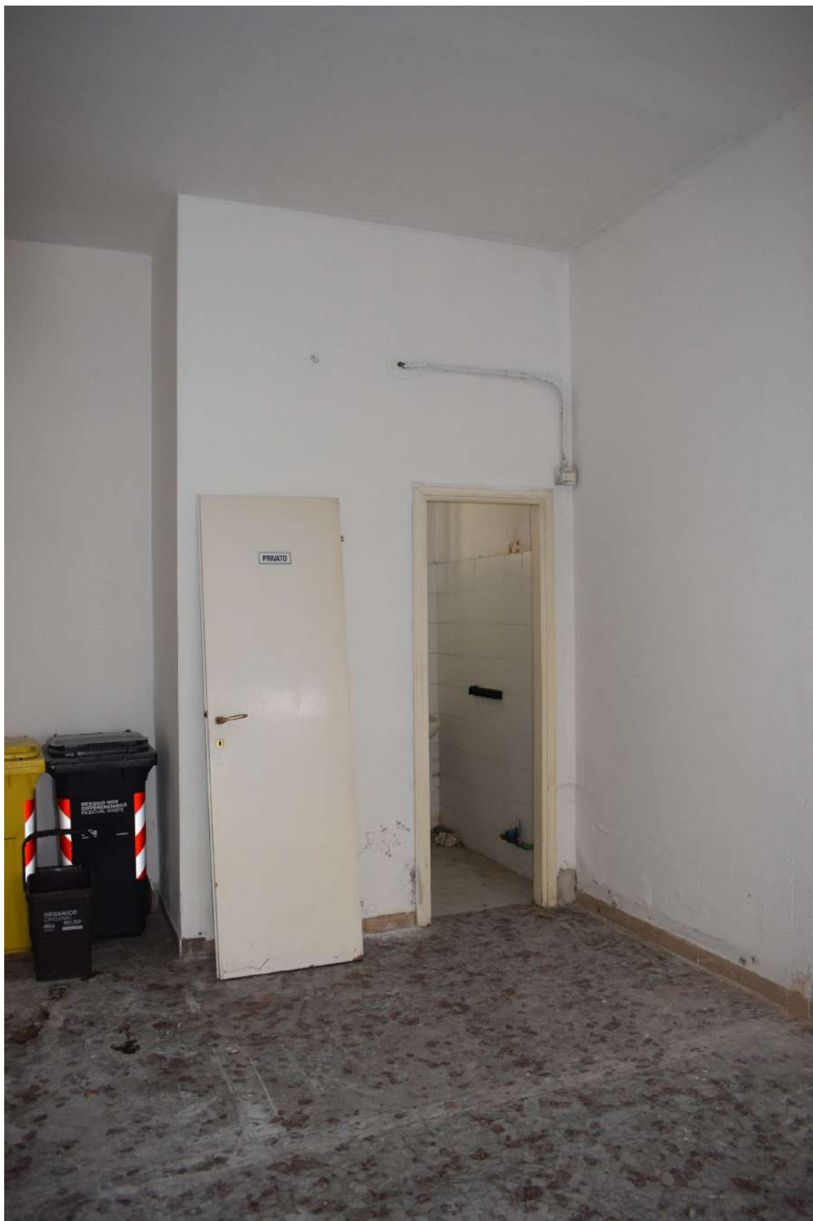
Foto n. 13 _ Sopralluogo del 13/02/2024 Zona bagno costituito da antibagno e wc
