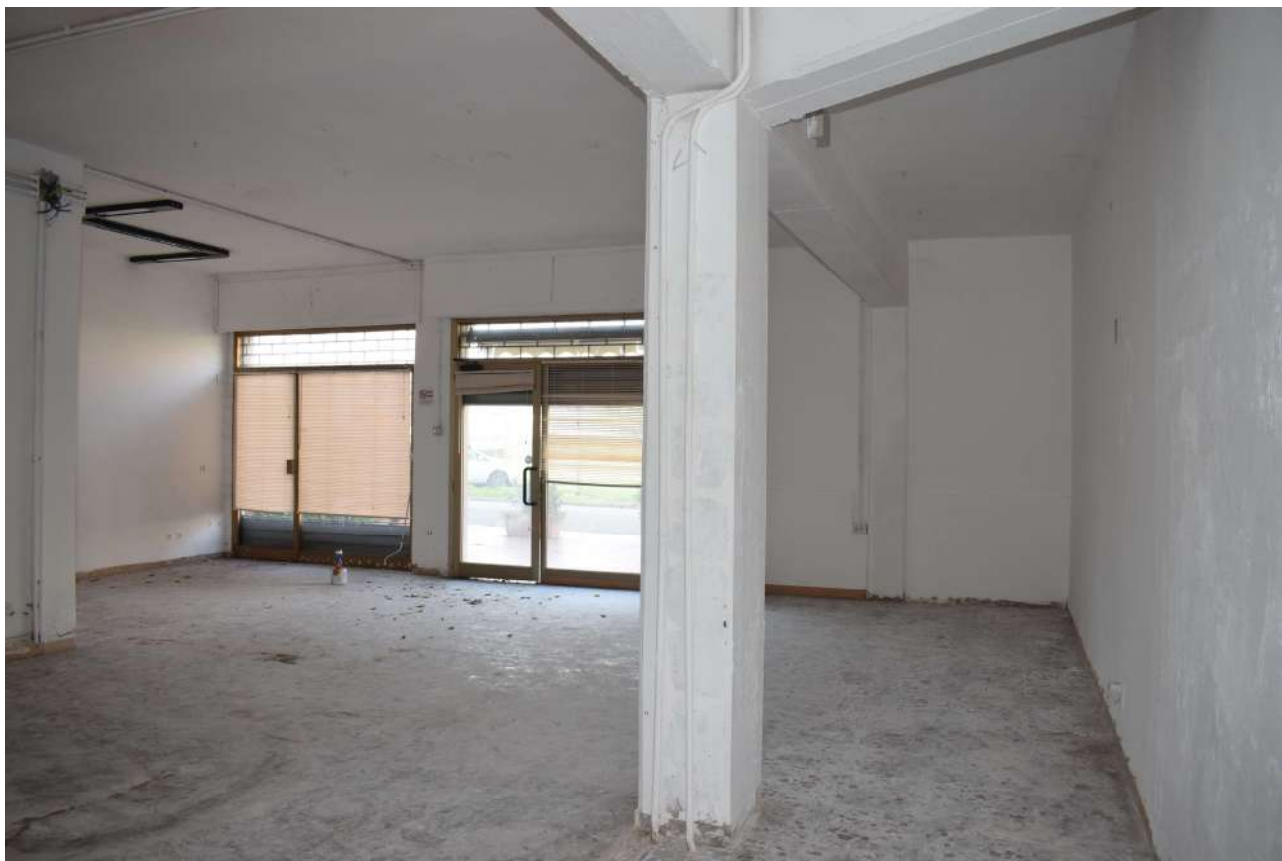
Foto n. 9 _ Sopralluogo del 13/02/2024 Il negozio - interni
