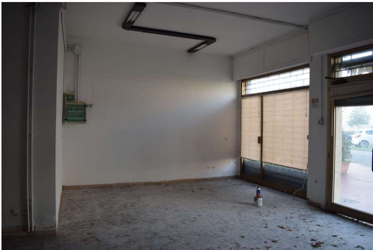
Foto n. 11 _ Sopralluogo del 13/02/2024 Il negozio - interni
