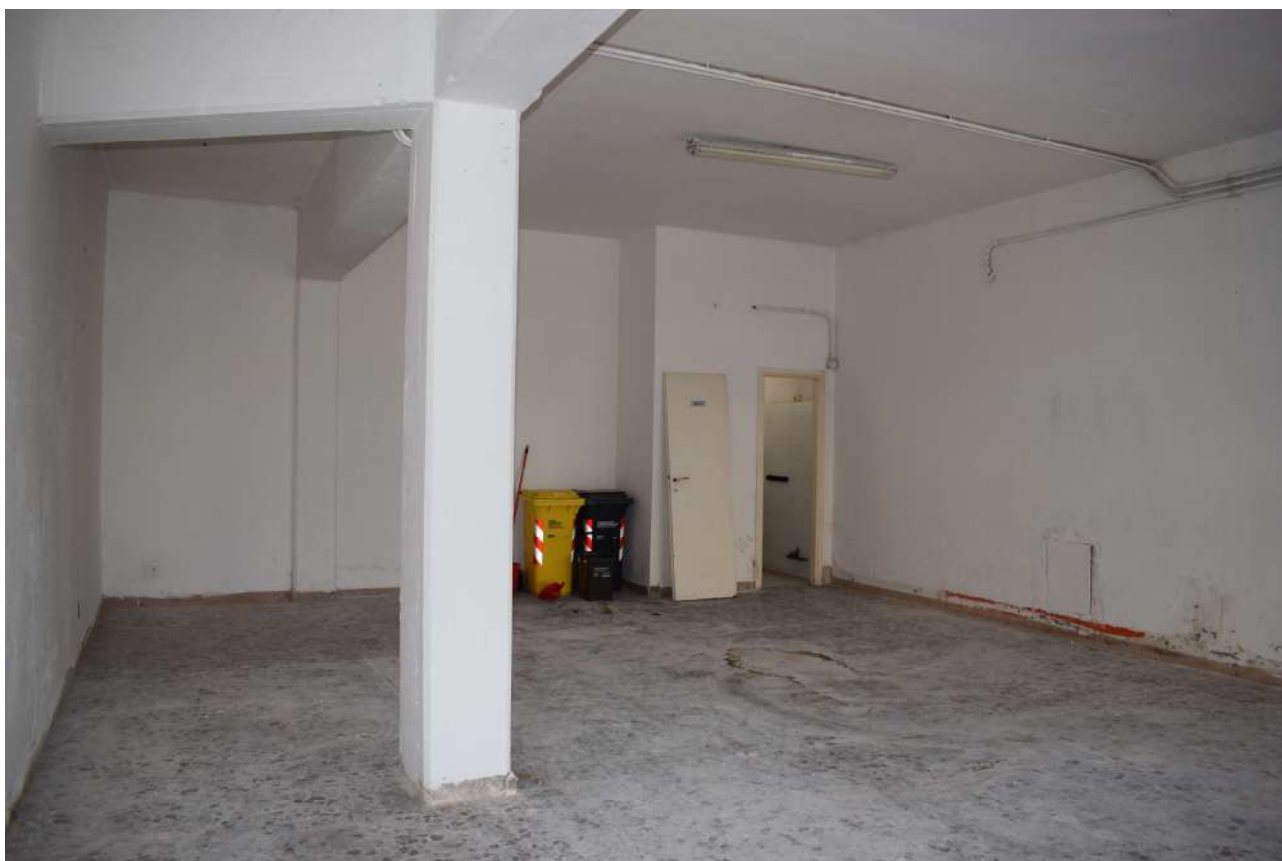
Foto n. 8 _ Sopralluogo del 13/02/2024 Il negozio - interni
