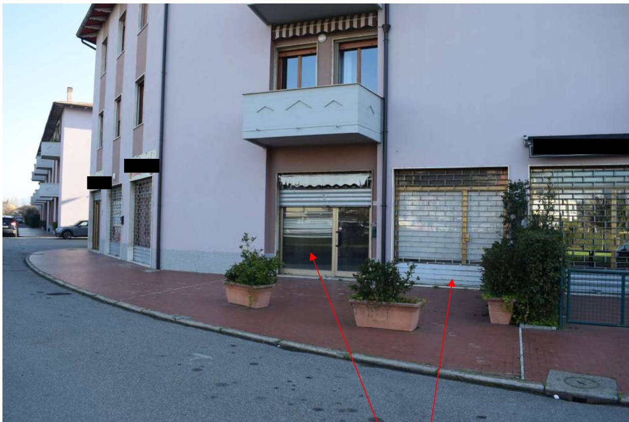
Foto n. 7 _ Sopralluogo del 13/02/2024 Il negozio al piano terra con due vetrine
