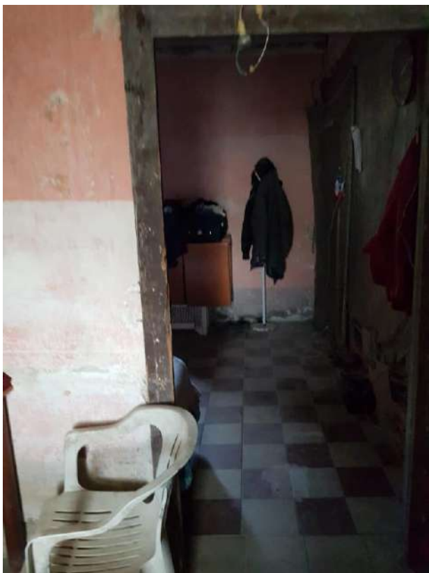
Foto 8 – Ambiente interno piano superiore
