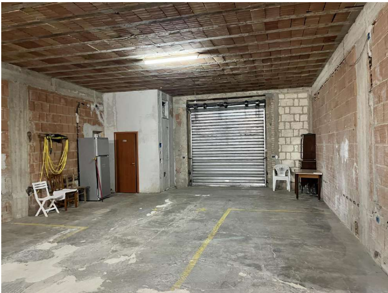
IMMAGINE 10: Immobile 1, locale autorimessa al piano terra
