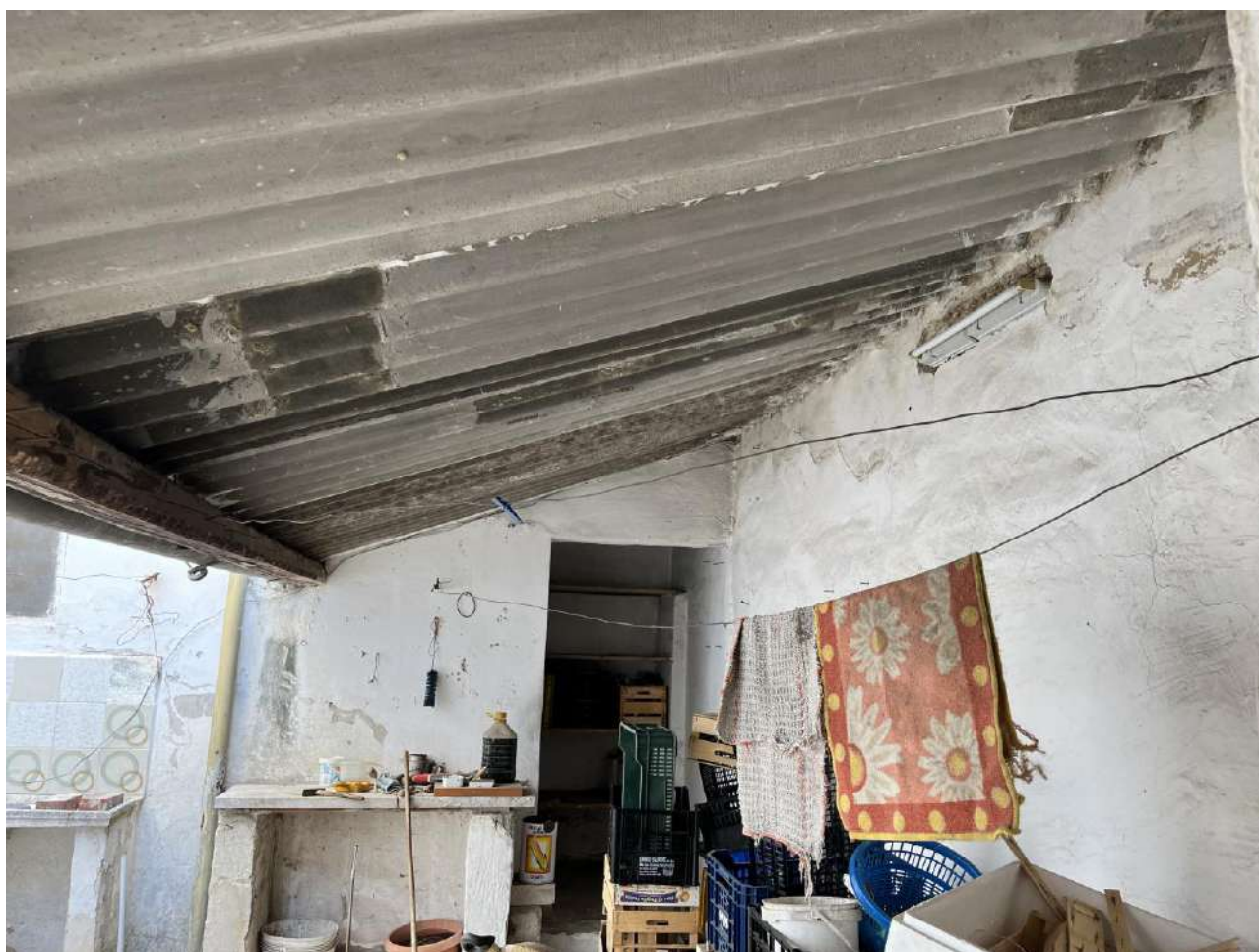
IMMAGINE 16: Cortile di pertinenza ubicato sul retroprospetto
