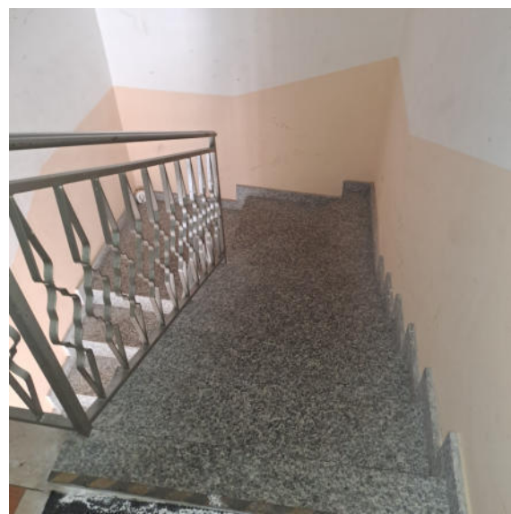
Foto 10 – Vano scala comune dal piano primo
