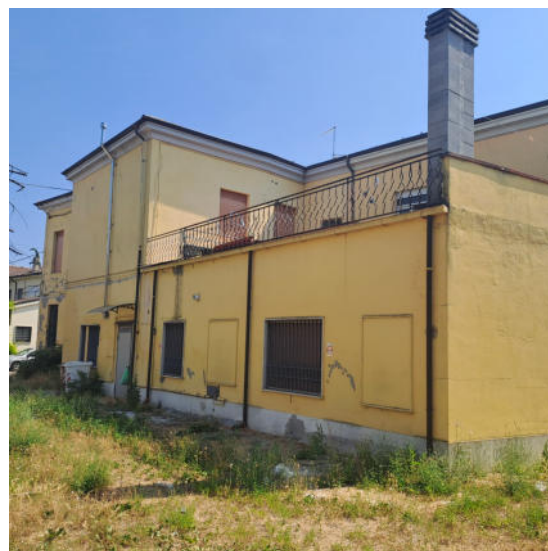
Foto 4 - Edificio dalla corte interna I-Lato ovest-sud
