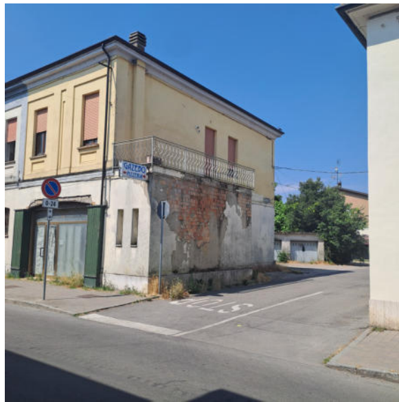
Foto 2- Edificio da Via Umberto I-Lato est-nord
