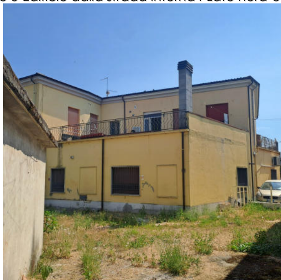
Foto 5 - Edificio dalla corte interna I-Lato ovest-sud
