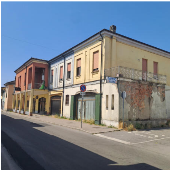
Foto 1-Edificio da Via Umberto I-Lato est-nord
