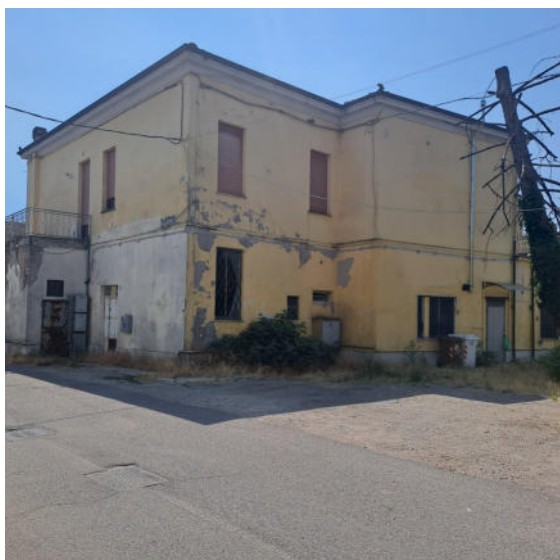
Foto 3-Edificio dalla strada interna I-Lato nord-ovest
