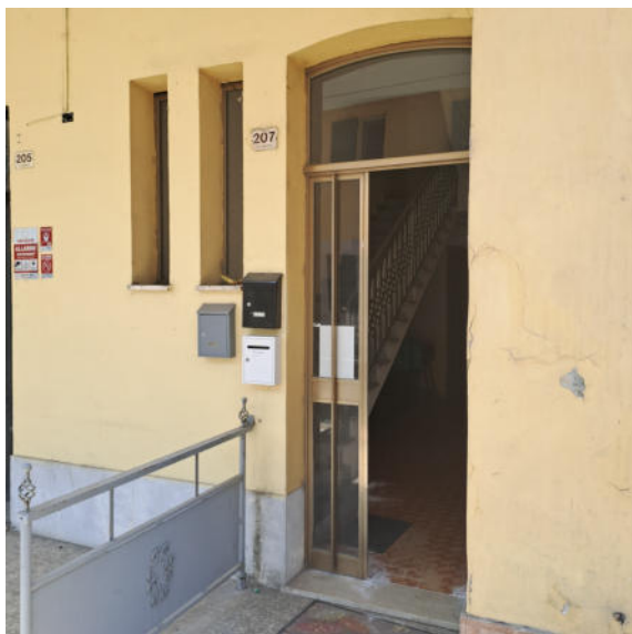
Foto 7-Ingresso condominiale da Via Umberto I
