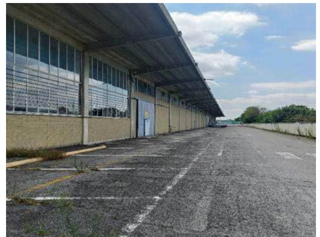
VISTA FRONTE EST COMPENDIO IMMOBILIARE
