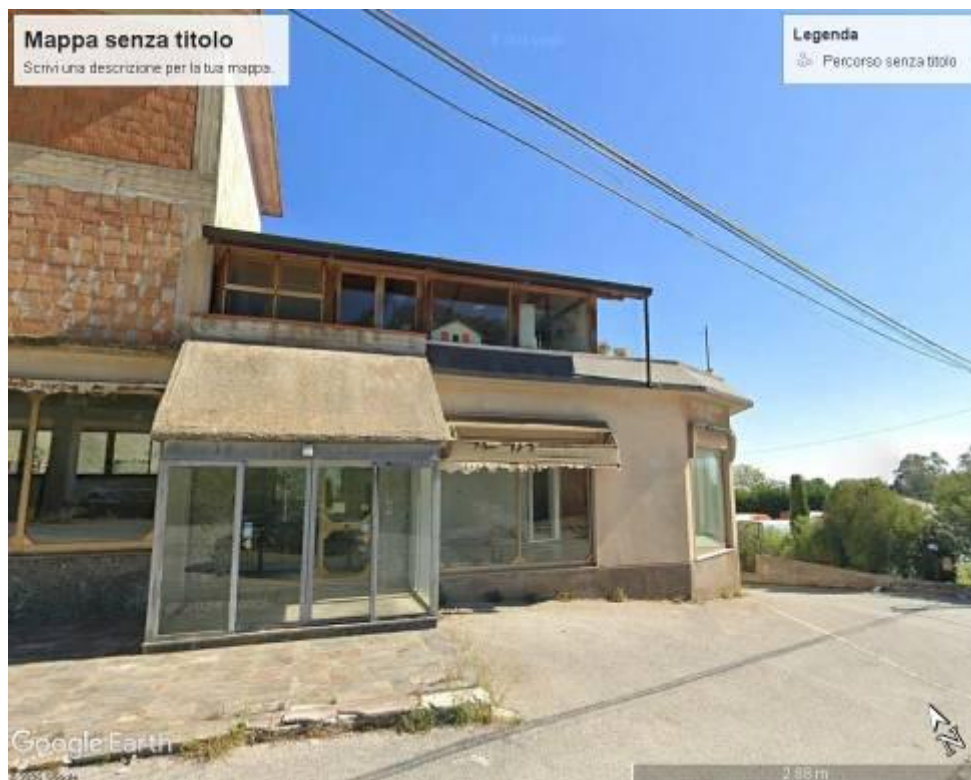
FOTO 1 (Tratta da Google earth)
