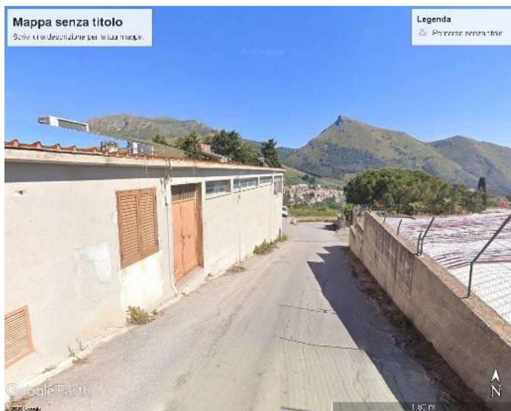
FOTO 3 (Tratta da Google earth)
