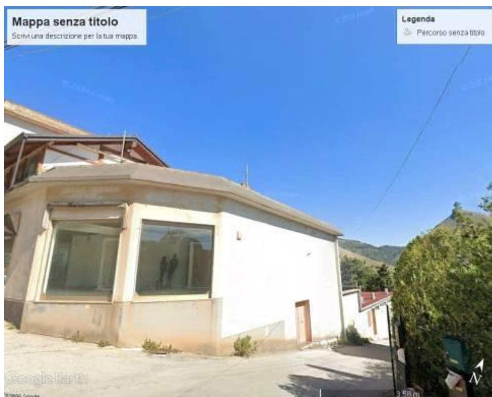
FOTO 2 (Tratta da Google earth)
