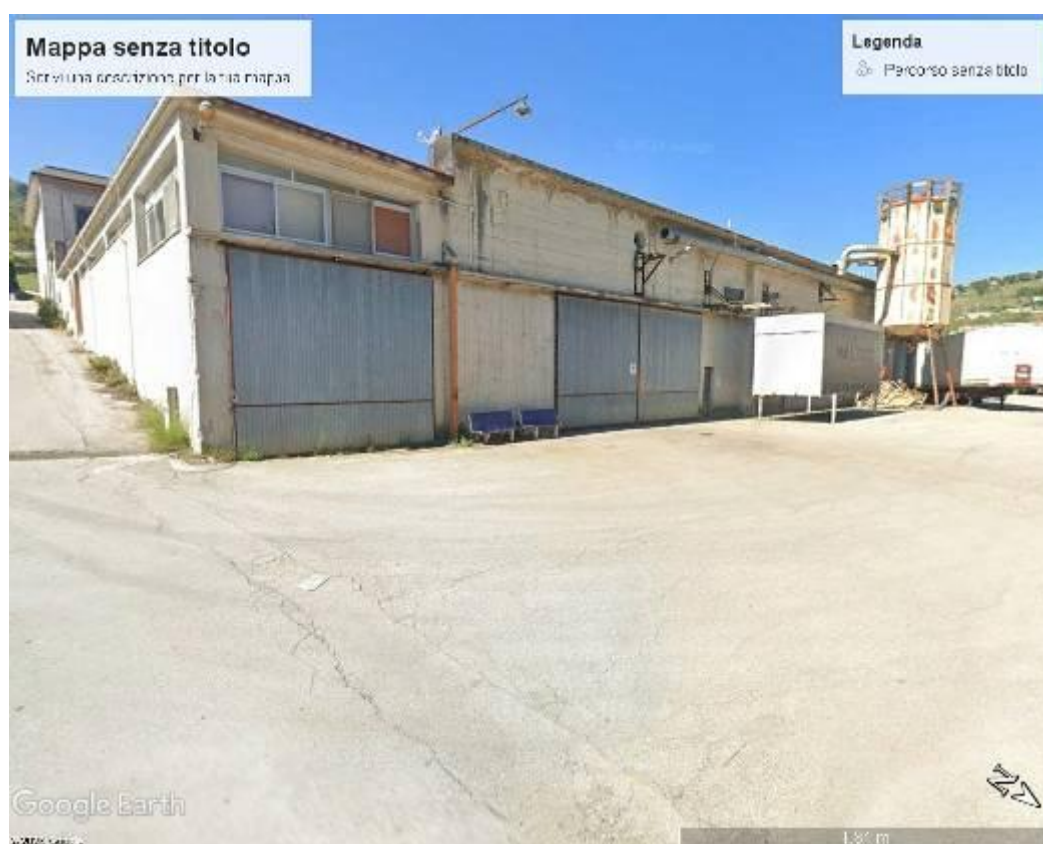
FOTO 4 (Tratta da Google earth)
