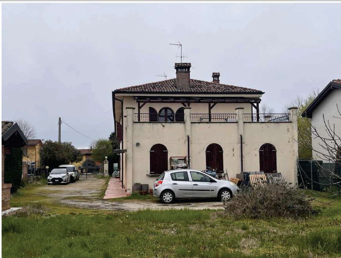
02_Fronte laterale (dal mappale adiacente non compreso)
