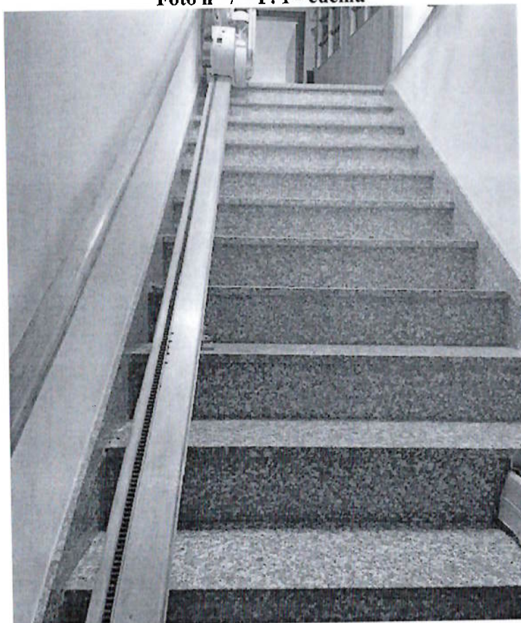
Foto n° 8 –scala tra P. 1 e 2
