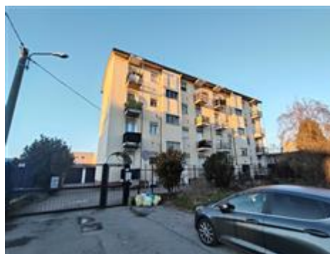
Particolare esterno edificio
