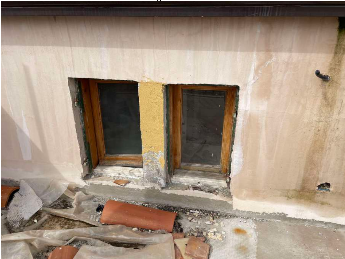
FOTO N. 35 – Affacci sul terrazzino del bagno e del cucinino – sub 4
