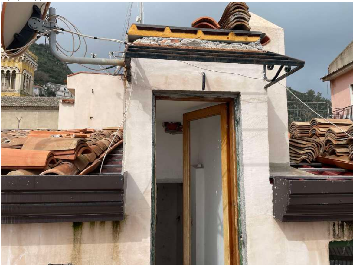
FOTO N. 36 – Accesso al terrazzino – sub 4
