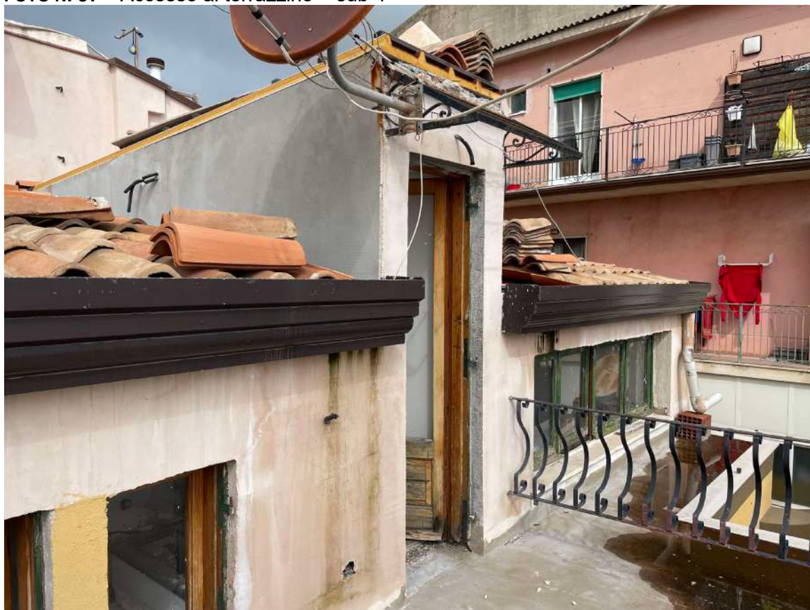
FOTO N. 37 – Accesso al terrazzino – sub 4
