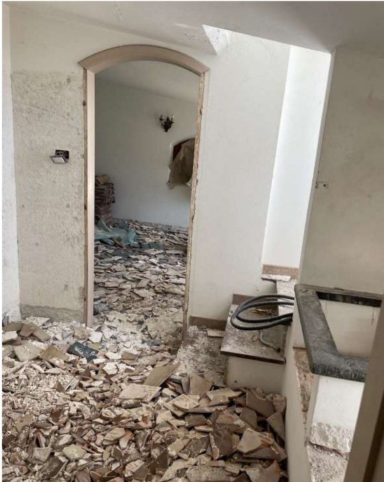
FOTO N. 31 – Vano cucina ed accesso al terrazzino– sub 4
