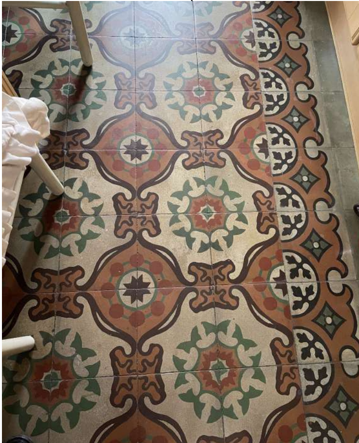
FOTO N. 17 – Particolare della pavimentazione della cucina
