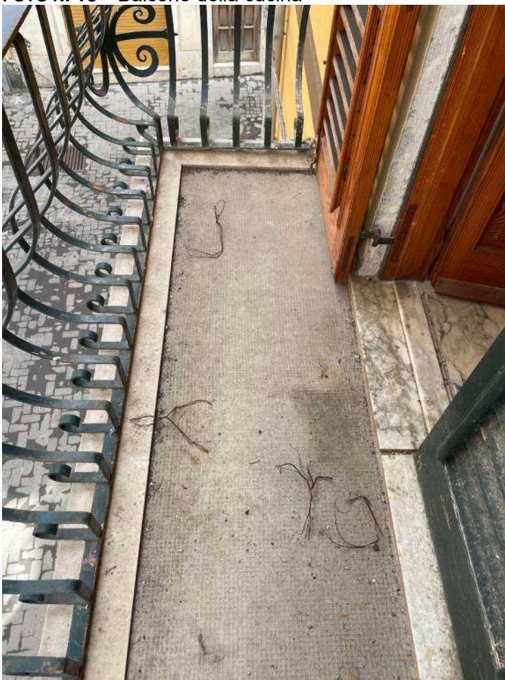
FOTO N. 18 – Balcone della cucina
