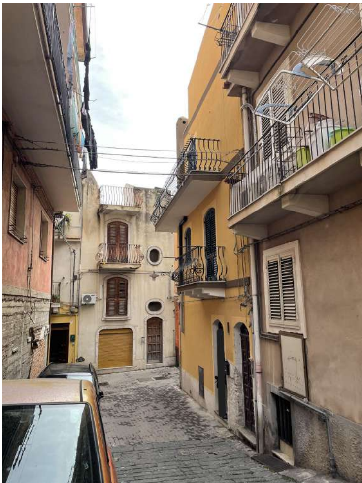
FOTO N. 2 – Vista del fronte di accesso al fabbricato su Via Vecchio Macello
