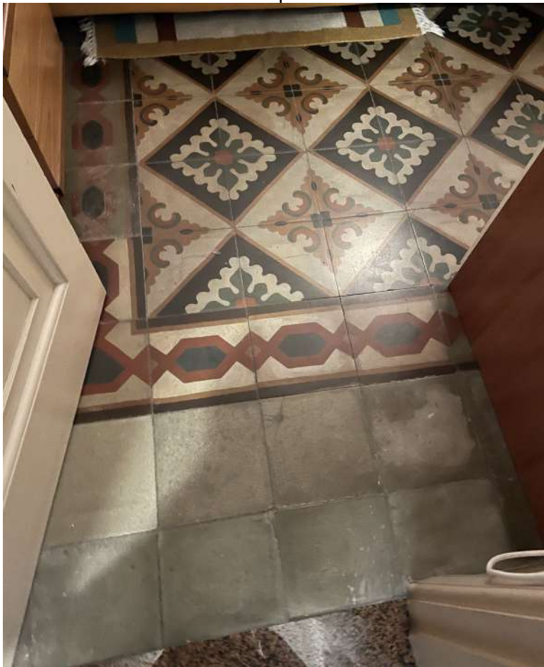
FOTO N. 11 – Particolare della pavimentazione della camera
