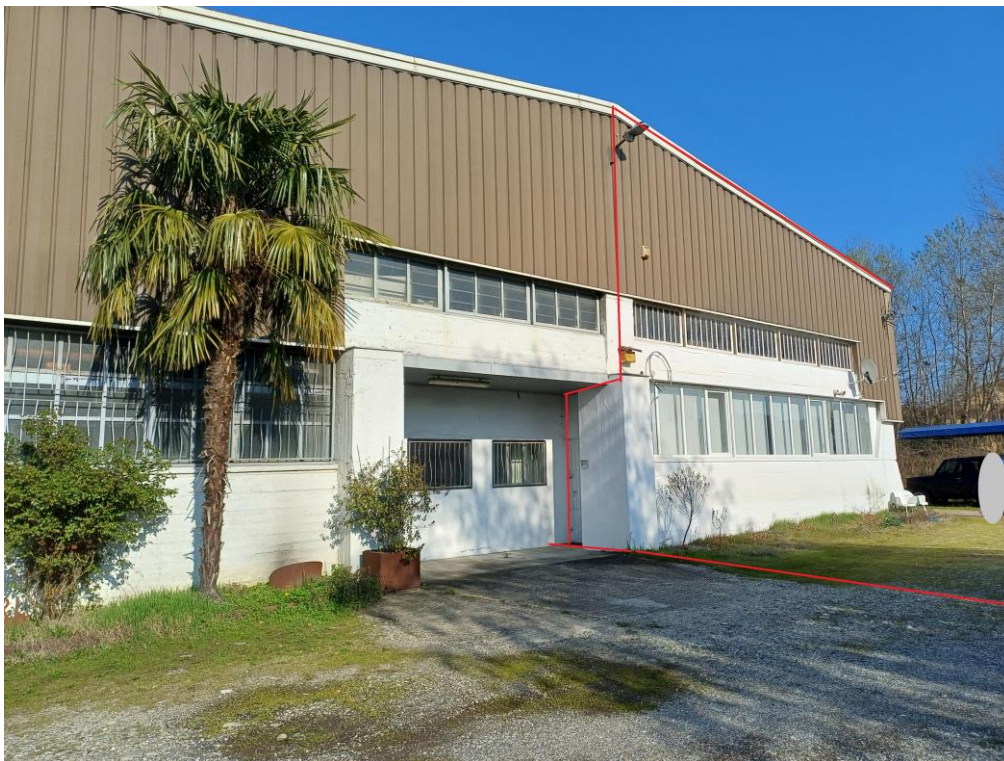
Foto 5 – Cortile e porzione capannone oggetto di perizia
