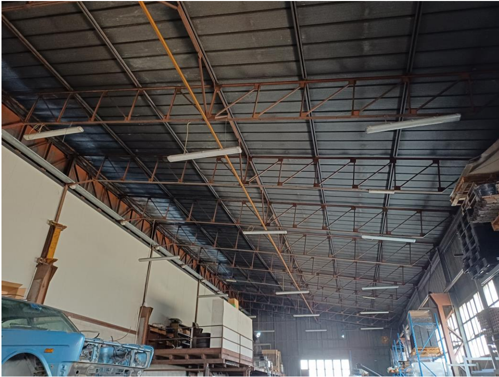
Foto 22 – Struttura portante del tetto
