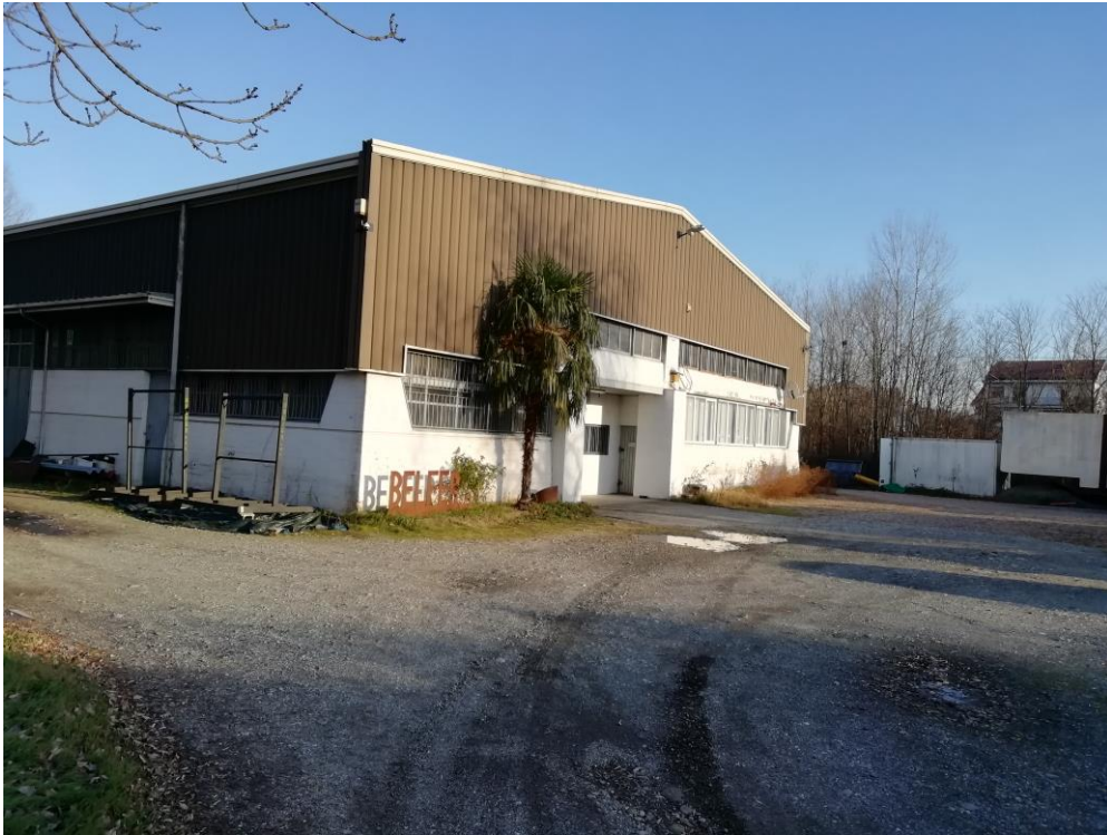
Foto 4 – Cortile di accesso
