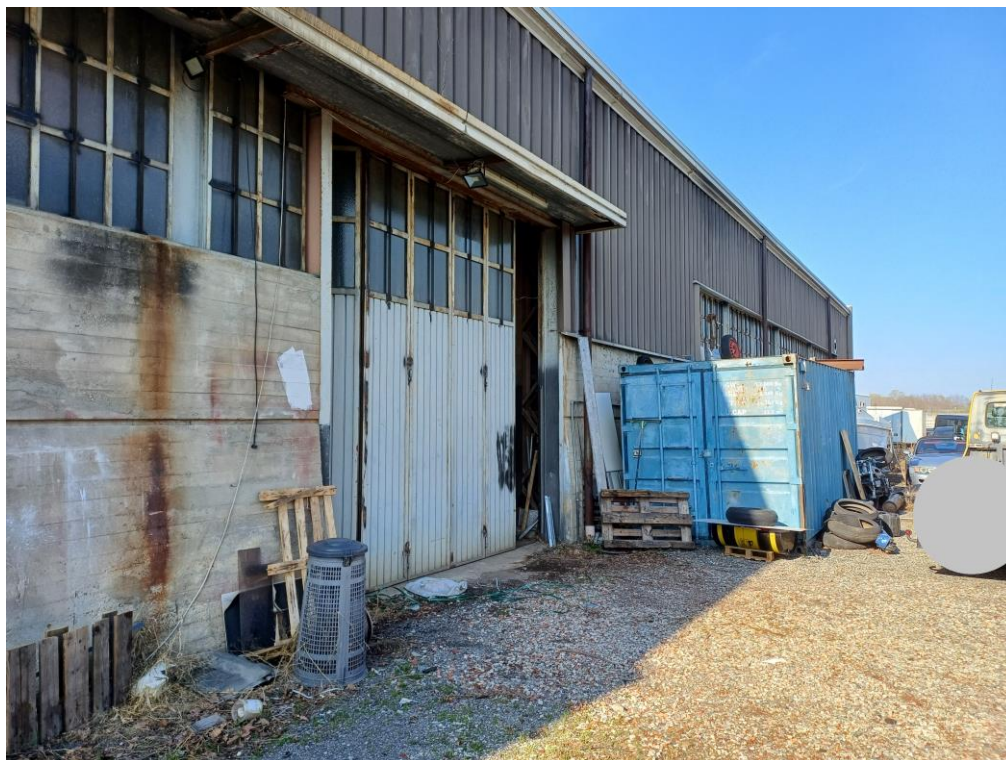
Foto 7 – Lato lungo con portone di ingresso
