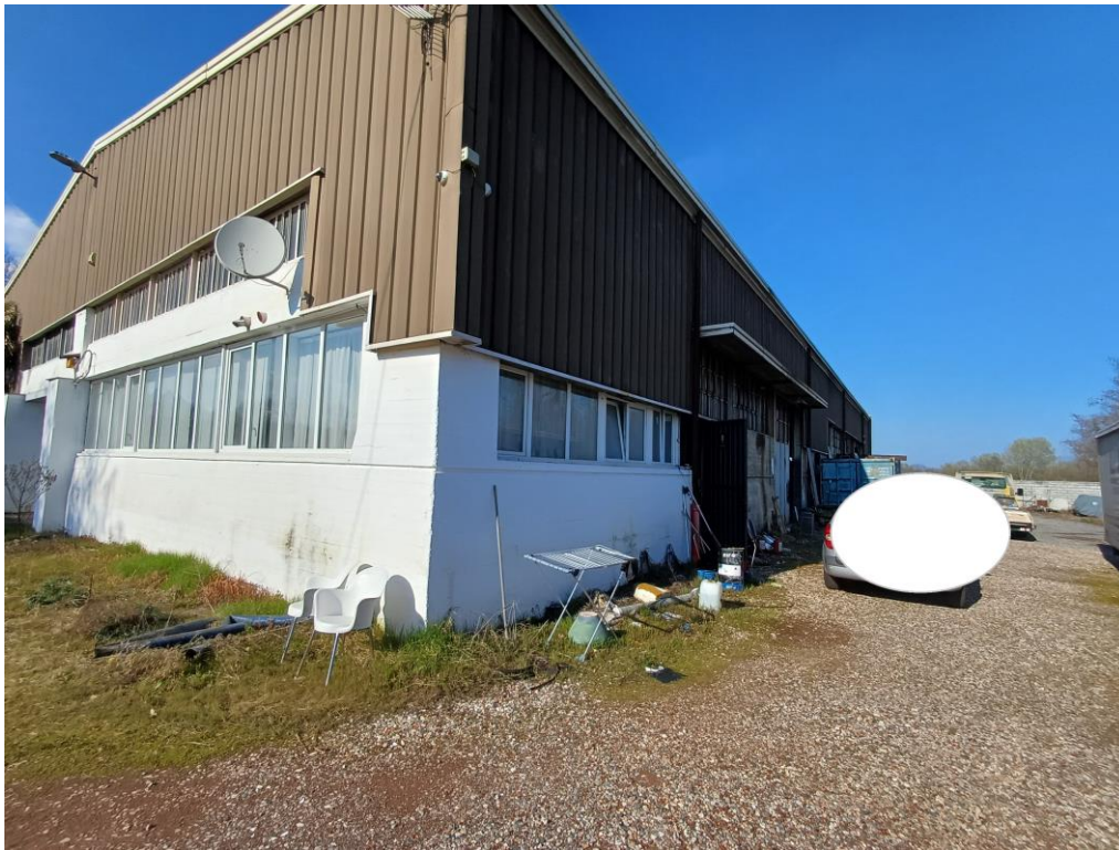
Foto 6 – Lato corto e lato lungo del capannone
