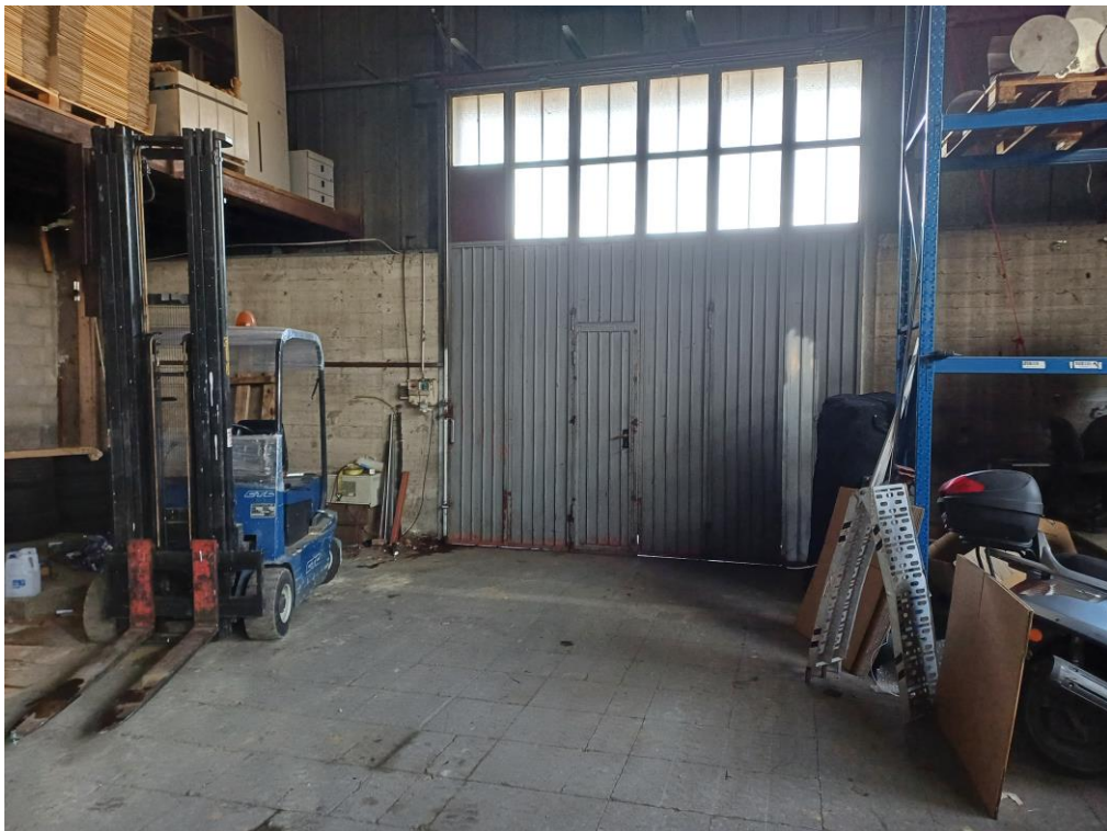
Foto 23 – Portone posteriore del capannone
