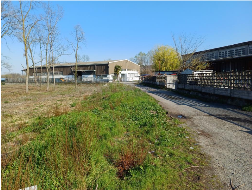
Foto 2 – Vista generale del fabbricato con strada di accesso
