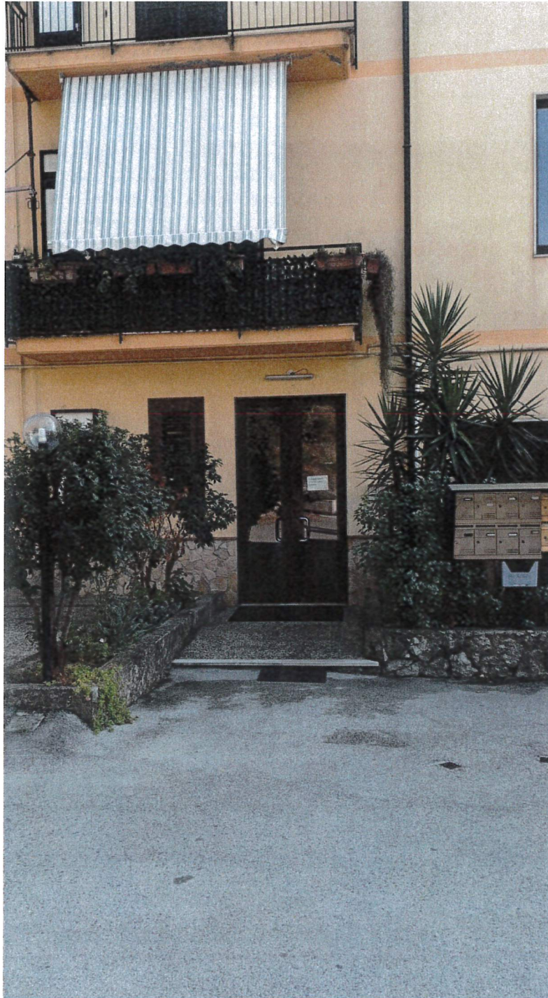
Foto n.3 - Vista accesso fabbricato
