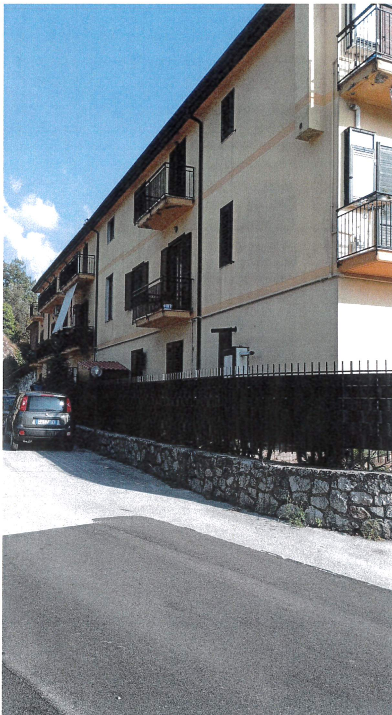
Foto n.2 - Vista laterale fabbricato
