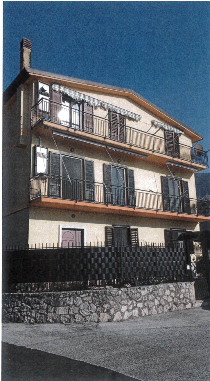
Foto n.1 - Vista principale del fabbricato
