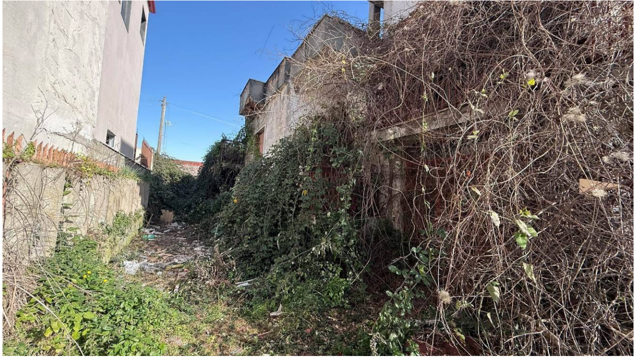
Foto 05 – Il fabbricato dal giardino pertinenziale p.IIa 1837 CT
