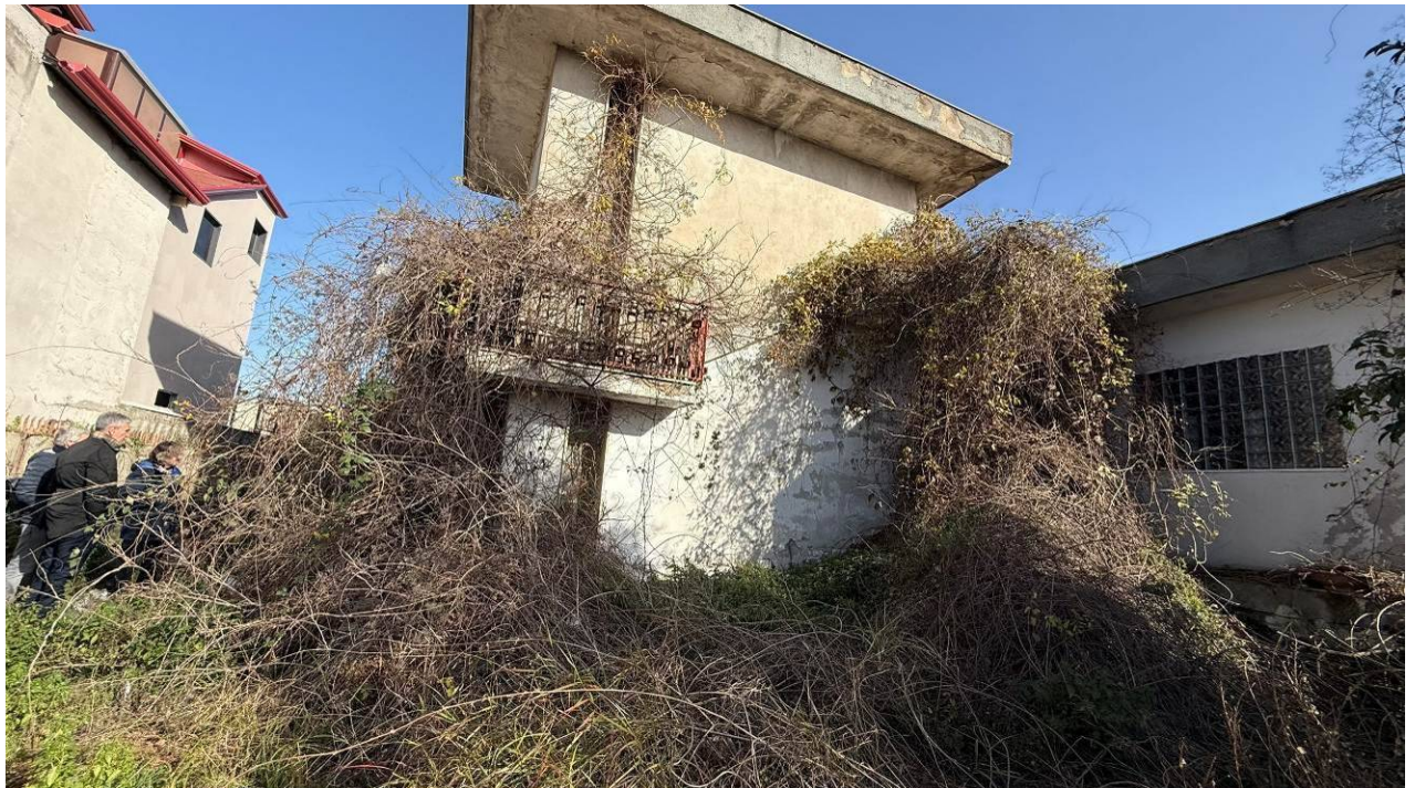
Foto 06 – Il fabbricato dal giardino pertinenziale p.IIa 1837 CT
