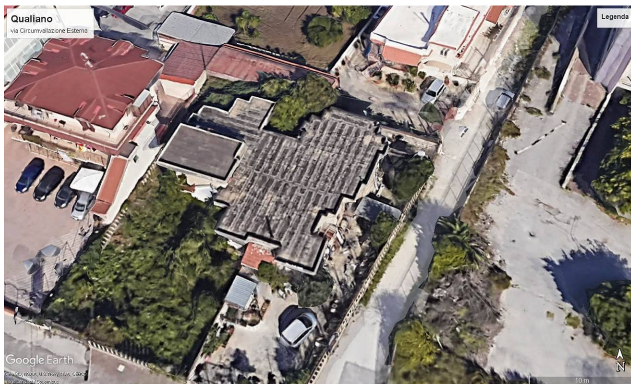
Foto 39 – Lastrico solare sub 2
