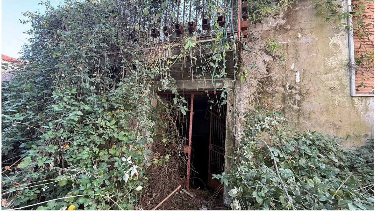
Foto 19 – Ingresso al sub 4 dal giardino pertinenziale p.lla 1837 CT
