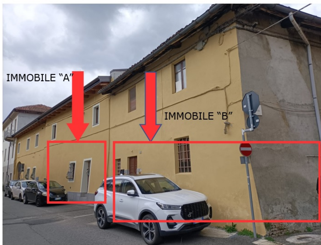
FOTOGRAFIA PROSPETTO SU VIA ITALIA
