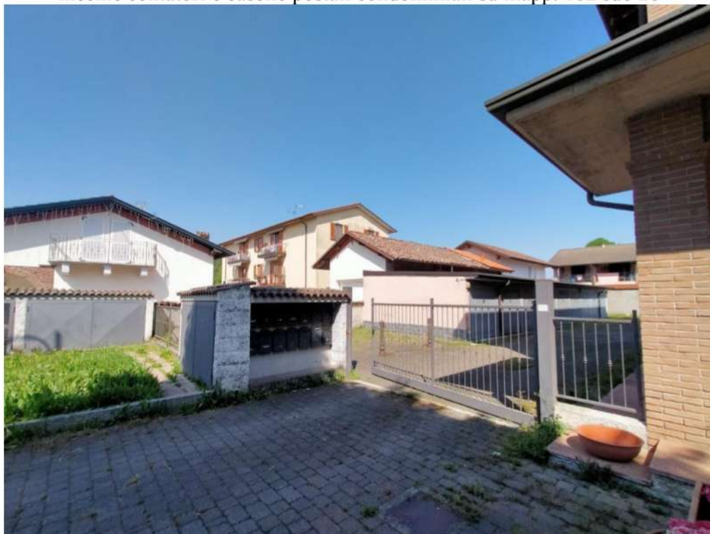
FOTO N°3 – accesso carraio e nicchie contatori e caselle postali condominiali su mapp. 182 sub 28
