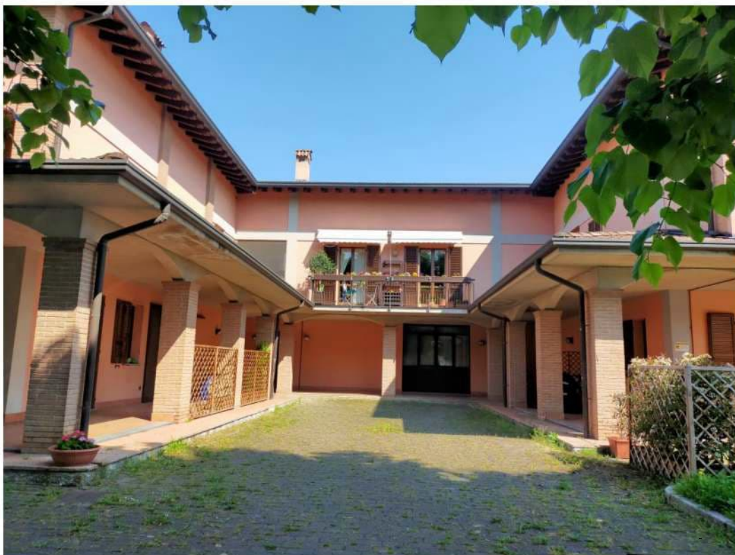
FOTO N° 1 – porticato mapp. 182 sub. 36 Area scoperta mapp. 619 sub. 5
