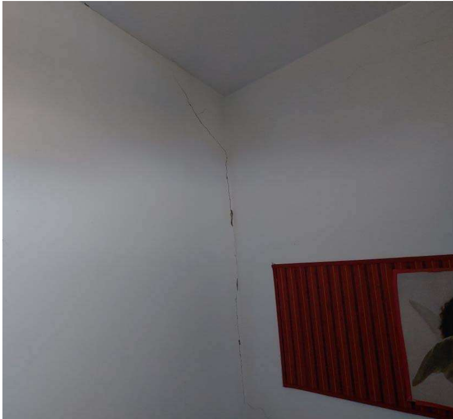
Foto dettaglio lesioni da cedimenti strutturali
