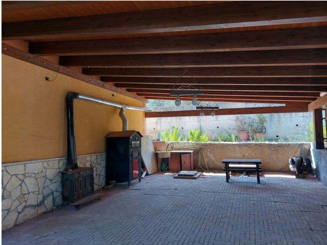
Foto tettoia lignea addossata al prospetto Sud-Ovest
