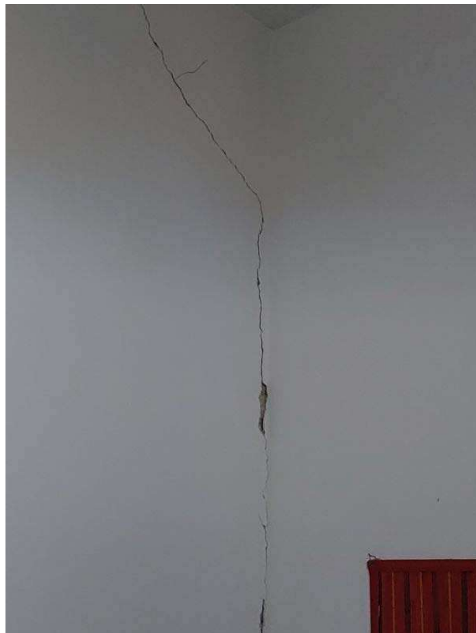
Foto dettaglio lesioni da cedimenti strutturali
