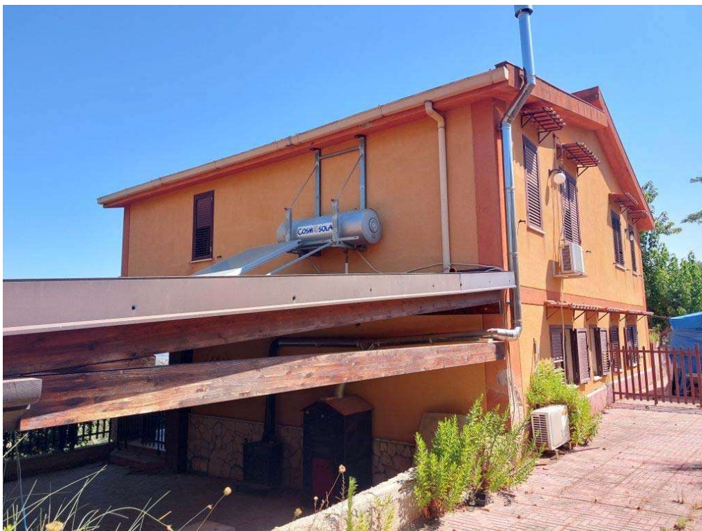
Foto Prospetto Sud-Ovest angolo Sud-Est
