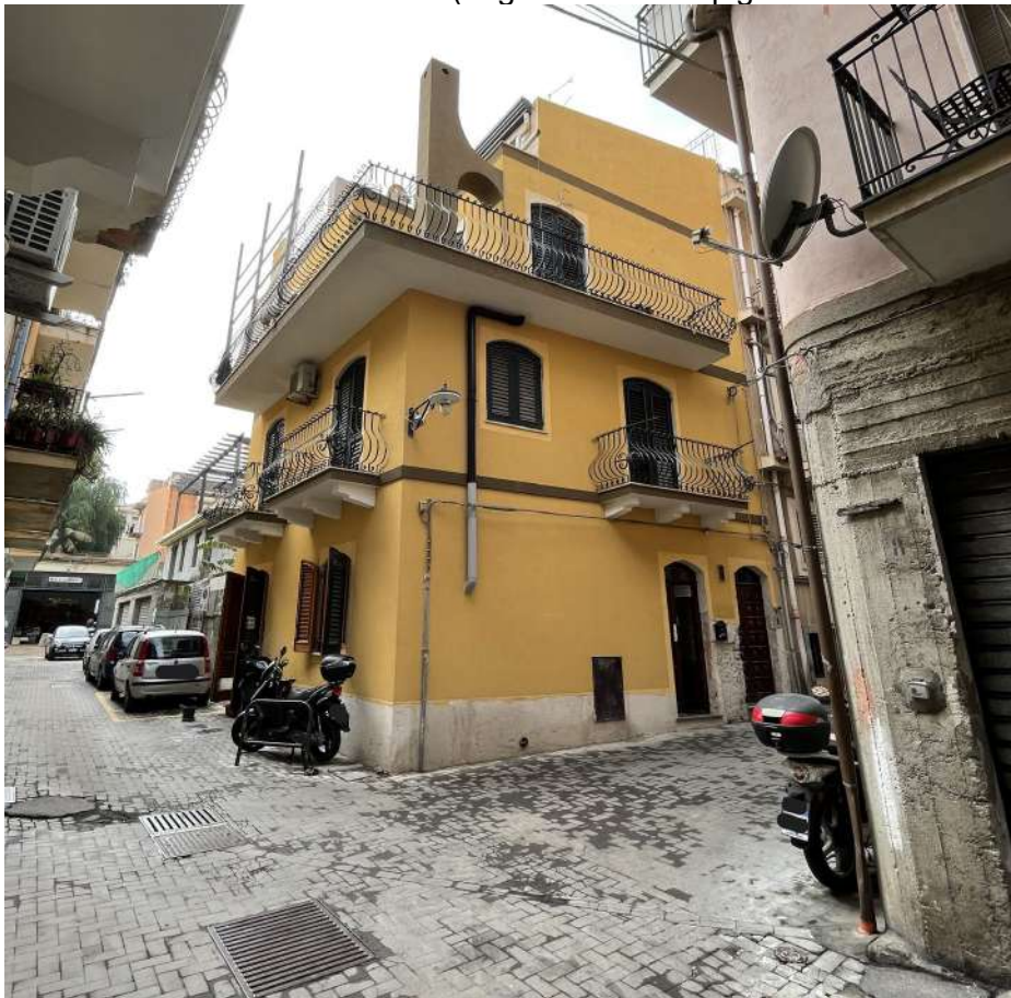
FOTO N. 1 – Vista del fabbricato (angolo tra Via Silipigni e Via Vecchio Macello)
