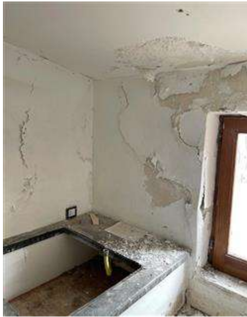
Particolare della zona perimetrale esterna del vano cucina
