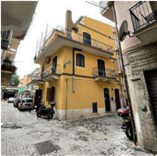
Vista del fabbricato (angolo tra Via Silipigni e Via Vecchio Macello)
