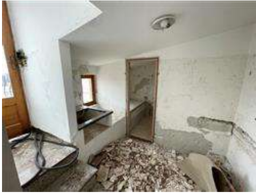
Vano cucina con accesso al terrazzino
