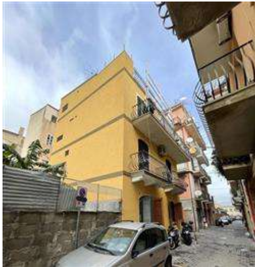
Vista del fabbricato su Via Silipigni
