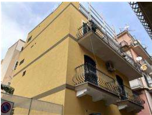
Vista della parte alta del fabbricato su Via Silipigni
