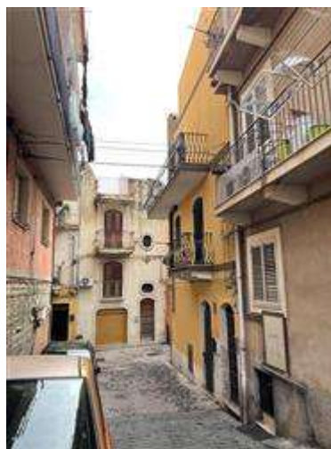
Vista del fronte di accesso al fabbricato su Via Vecchio Macello
