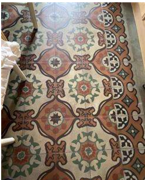
Particolare della pavimentazione della cucina
