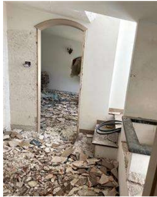
Vano cucina con accesso al terrazzino
