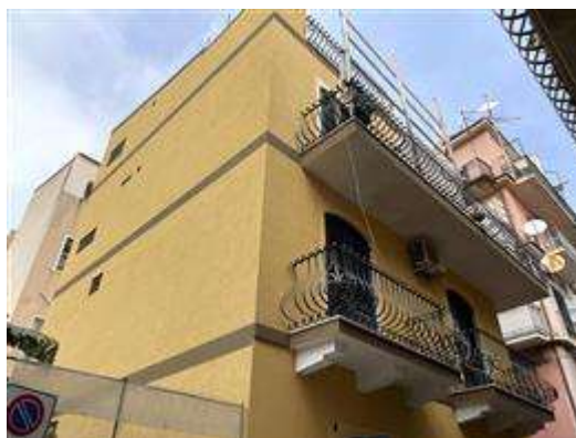
Vista della parte alta del fabbricato su Via Silipigni
