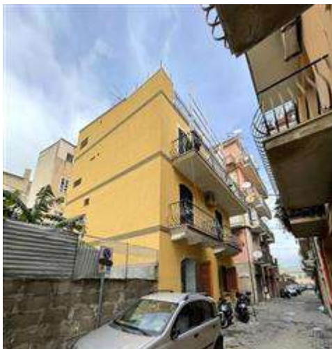
Vista del fabbricato su Via Silipigni
