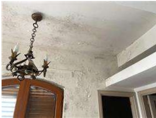
Particolare della parete perimetrale su Via Silipigni
