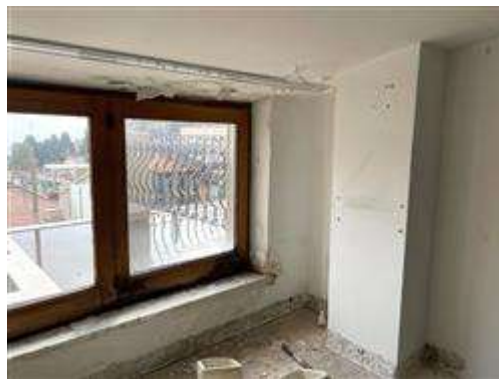
Particolare della zona perimetrale esterna
