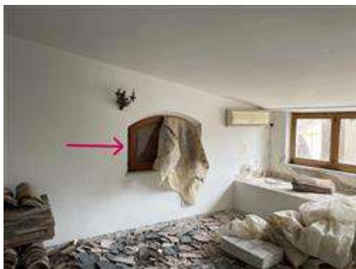
Finestra murata (fronte su Via Vecchio Macello)
