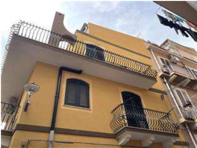
Vista della parte alta del fabbricato su Via Vecchio Macello
