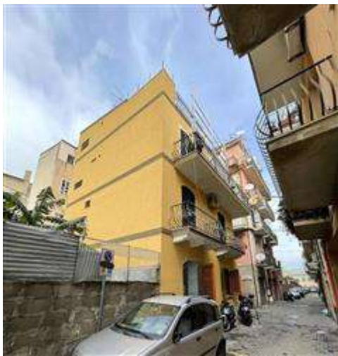
Vista del fabbricato su Via Silipigni
