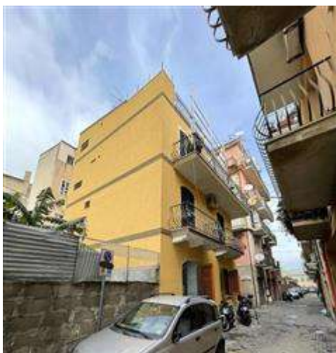
Vista del fabbricato su Via Silipigni
