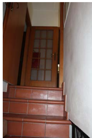
VEDUTA DELLA SCALA DI COLLEGAMENTO TRA PIANO TERRA E PRIMO
