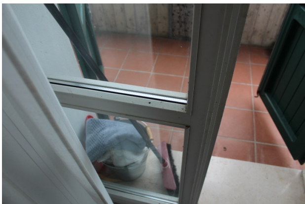
VEDUTA DEL BALCONE CON ACCESSO DALLA CUCINA
