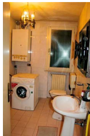
VEDUTA DEL BAGNO AL PIANO TERRA
