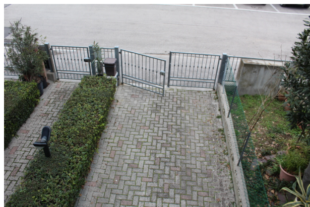
PARTICOLARE DEI CANCELLI DI ACCESSO ALLA PROPRIETA'
