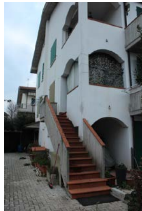
VEDUTA DELLA SCALA DI ACCESSO ALL'ABITAZIONE
