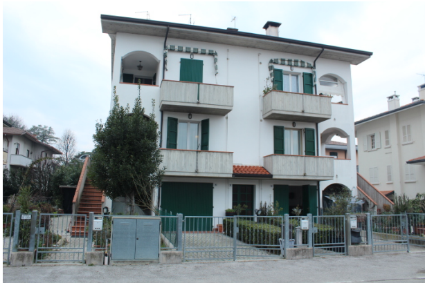
VEDUTA, DA VIA MORETTI, DELLA PALAZZINA OVE SONO UBICATE LE U.I. OGGETTO DI PROCEDURA
