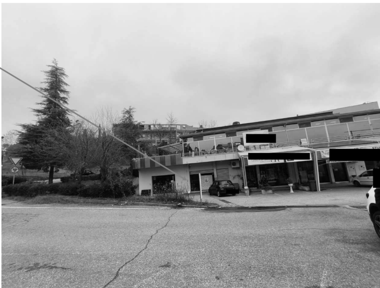
Foto n. 5: Immobile pignorato – prospetto principale
