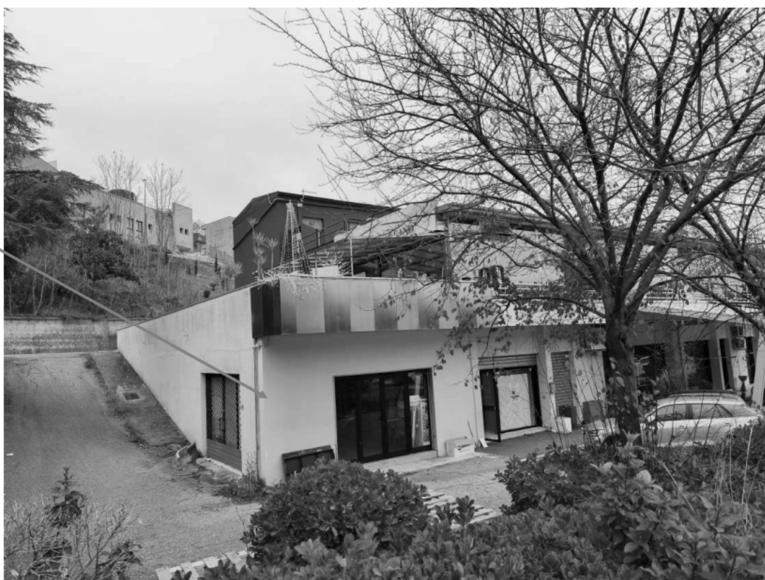
Foto n. 6: Immobile pignorato – visibili i quattro accessi
