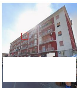
Foto n. 2 - Fabbriato in cui è ubicato l'immobile pignorato
