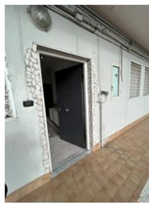
Foto n. 12 - Ballatoio comune d'accesso - accesso all'immobile pignorato
