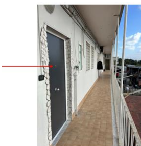
Foto n. 11 - Ballatoio comune d'accesso - accesso all'immobile pignorato
