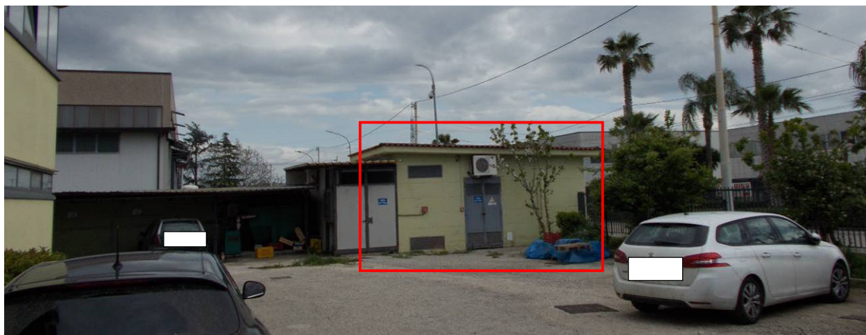
L'immobile sub 1 (C/2)
