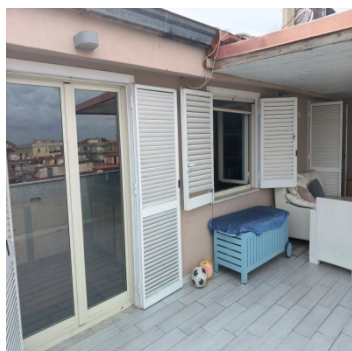
Pavimentazione terrazza e infissi
