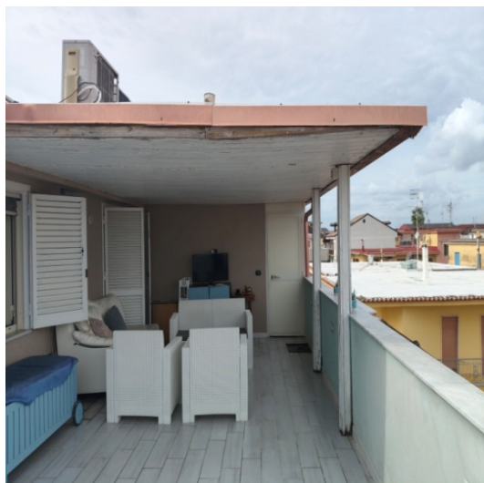
Terrazza grande a nord-vista tettoia
