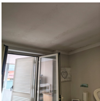
Dettaglio infissi esterni
