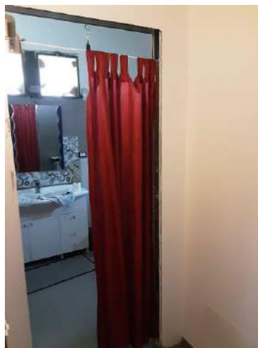
Foto 22 - BENE A) – Villino P.T. – Disimpegno su bagno
