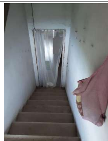
Foto 38 – BENE A) – Villino - Scala tra P.1° e sottotetto
