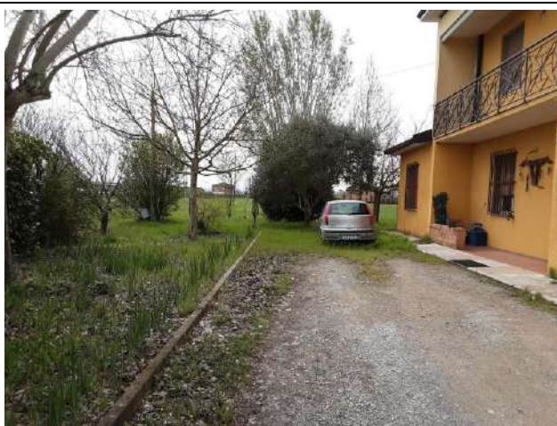
Foto 8 – Area cortiliva lato est
