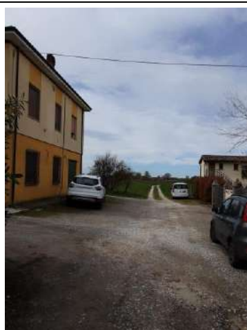
Foto 11 – Area cortiliva lato nord con servitù di passaggio
