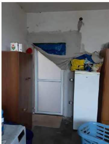
Foto 27 - BENE A) – Villino P.T. – Cantina 1
