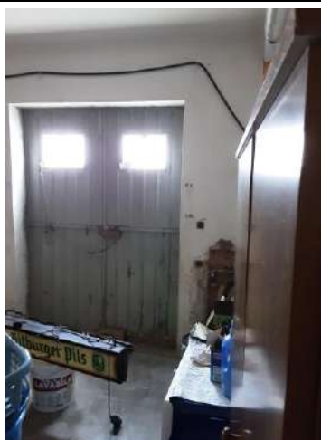
Foto 26 - BENE A) – Villino P.T. – Cantina 1
