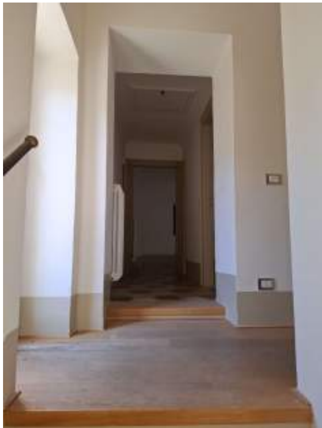
Foto 29 - 30 - 31 - 32 - Vista del disimpegno al piano primo
