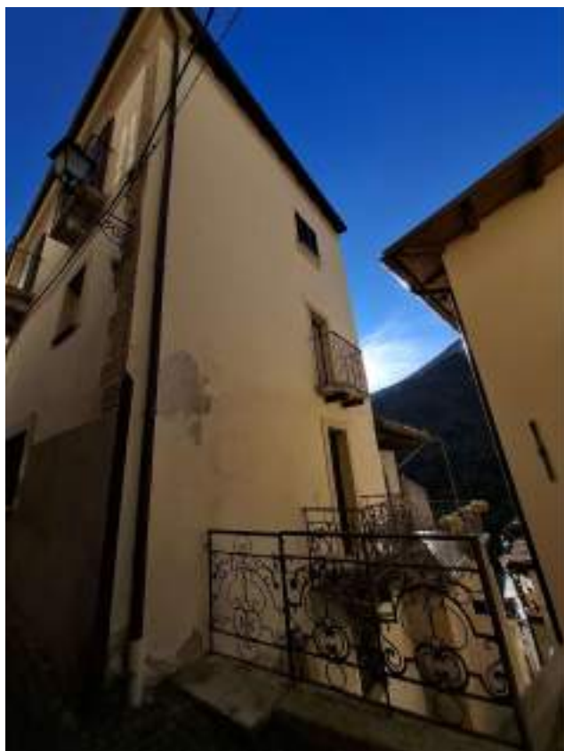
Foto 7 e 8 - Vista verso Via Mulino
