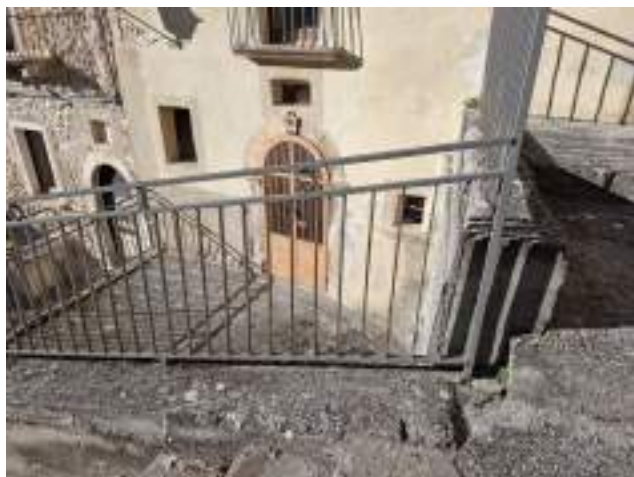
Foto 5 - Vista dell'ingresso al magazzino da Largo Pace
