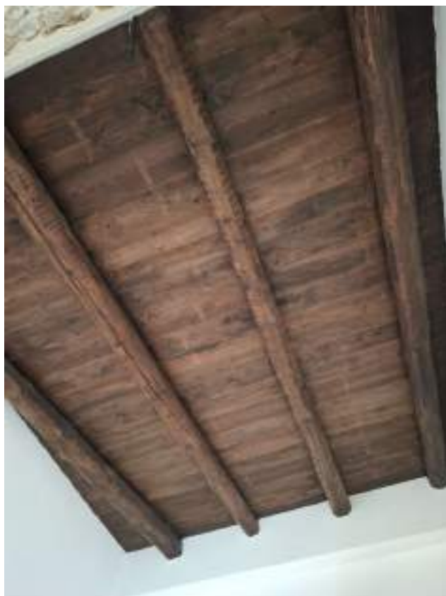
Foto 19 - Vista soffitto di pranzo soggiorno
