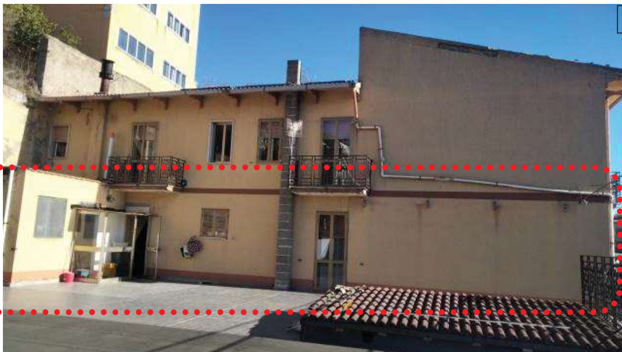
Abitazione al piano primo vista facciata dal terrazzo praticabile (facciata al piano secondo abitazione di proprietà OMISSIS esclusa dalla procedura di espropriazione immobiliare)
