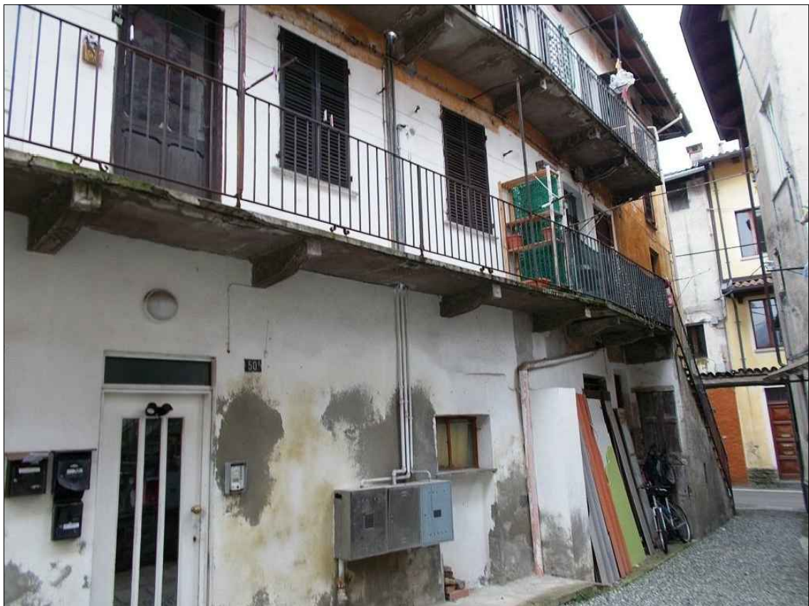
Esterno (da corte transitoria)
