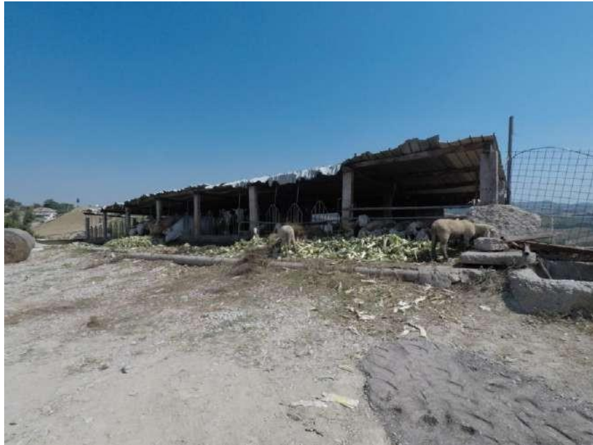
Prospetto Ovest EDIFICIO 5 (tettoia staccata uso stalla)
