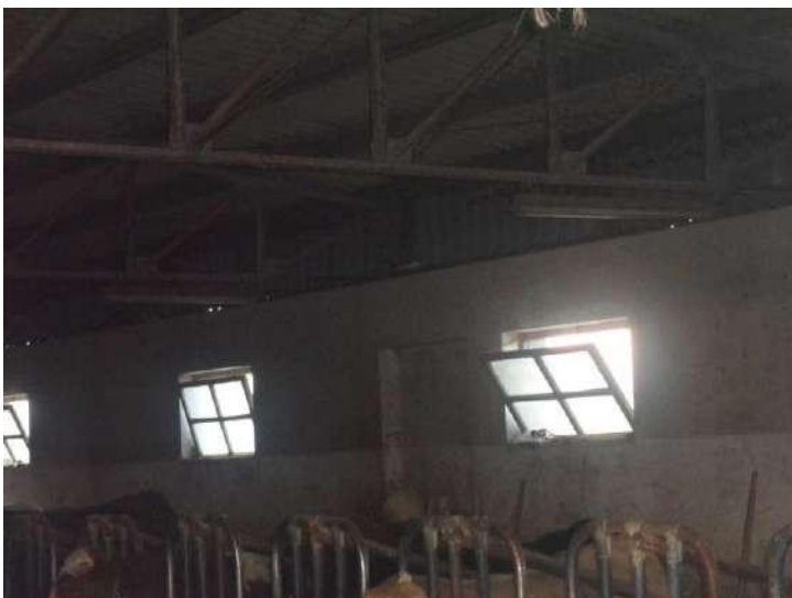
particolare struttura e aperture
