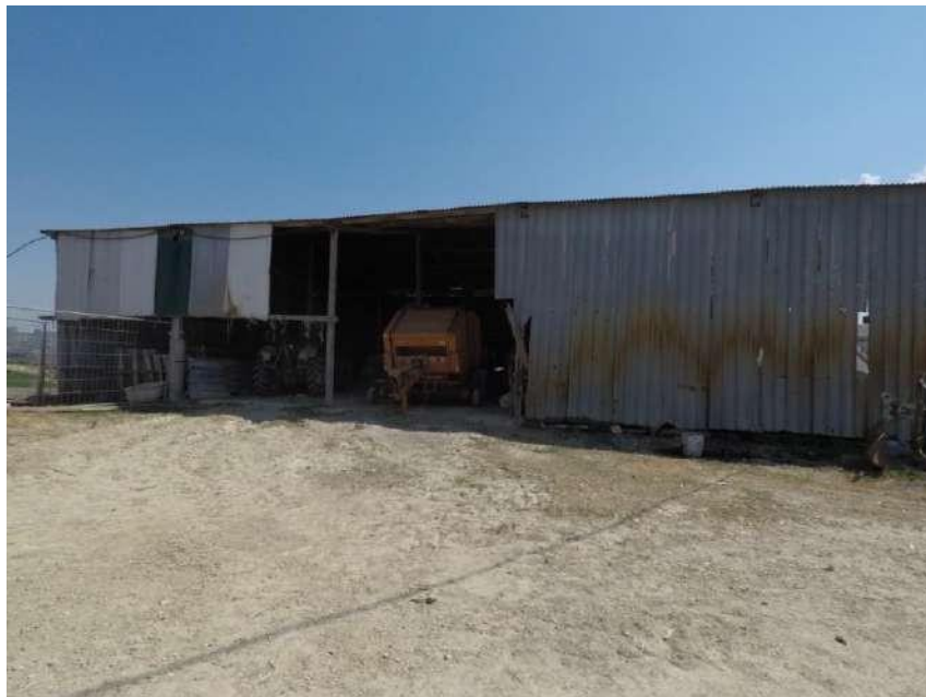
Prospetto Ovest EDIFICIO 3 (tettoia uso rimessa agricola)
