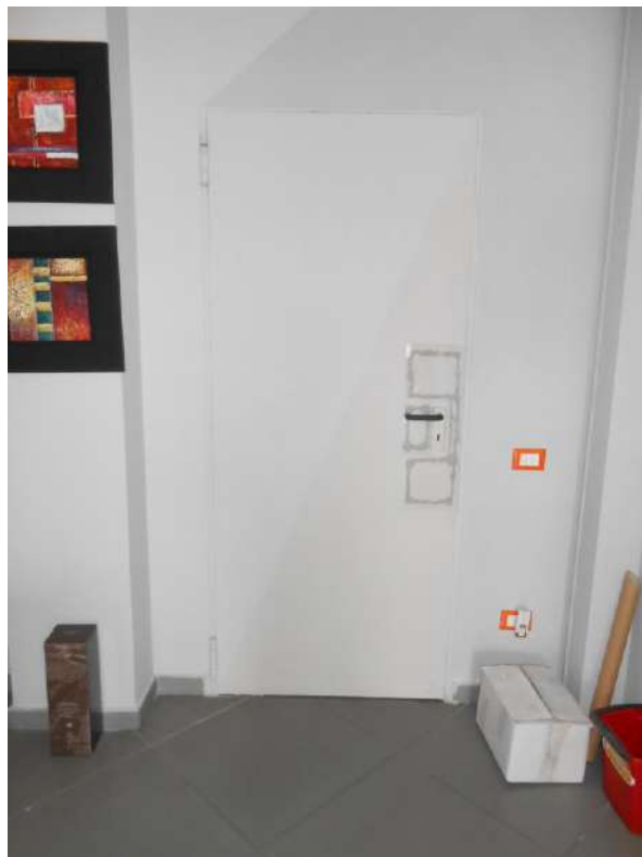
immagine 21 – porta metallica interna
