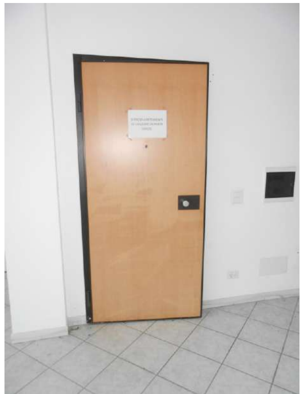
immagine 36 – portoncino di sicurezza da vano scala
