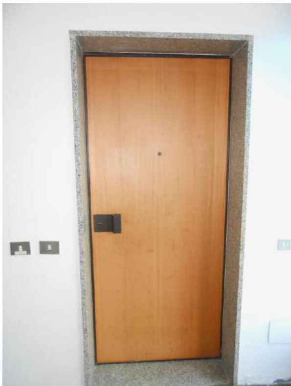
immagine 20 – portoncino di sicurezza da vano scala
