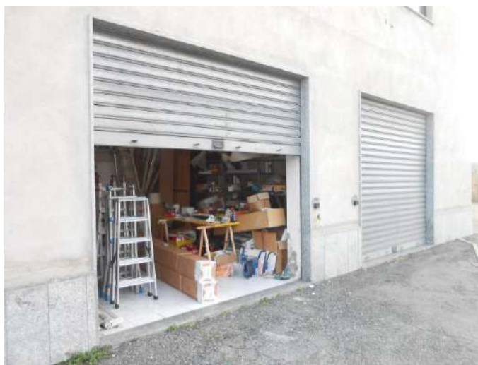
immagine 39 – veduta esterna accesso rimesse
