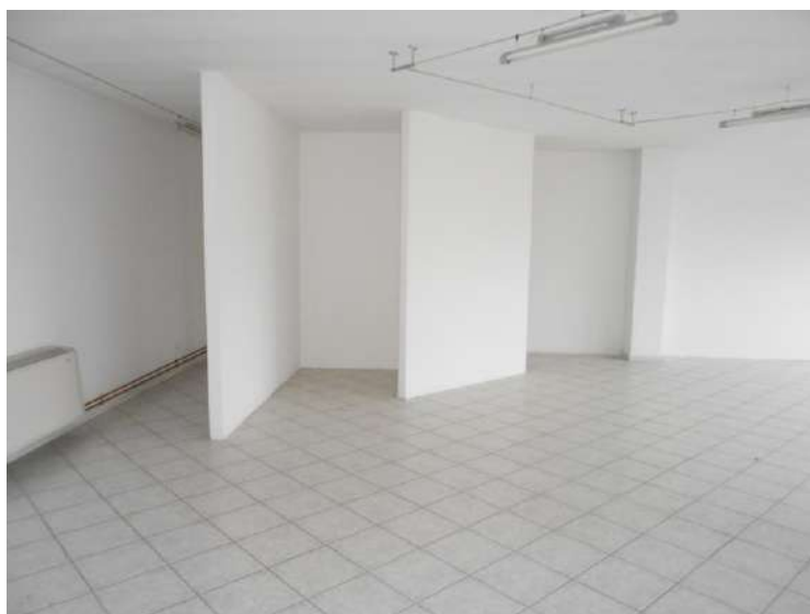
immagine 44 – realizzazione divisorio in cartongesso P1°
