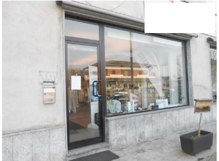
immagini 22 e 23 – particolare serramenti in alluminio/vetro
