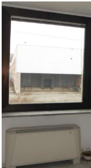
immagine 38 – dettaglio termoconvettore
