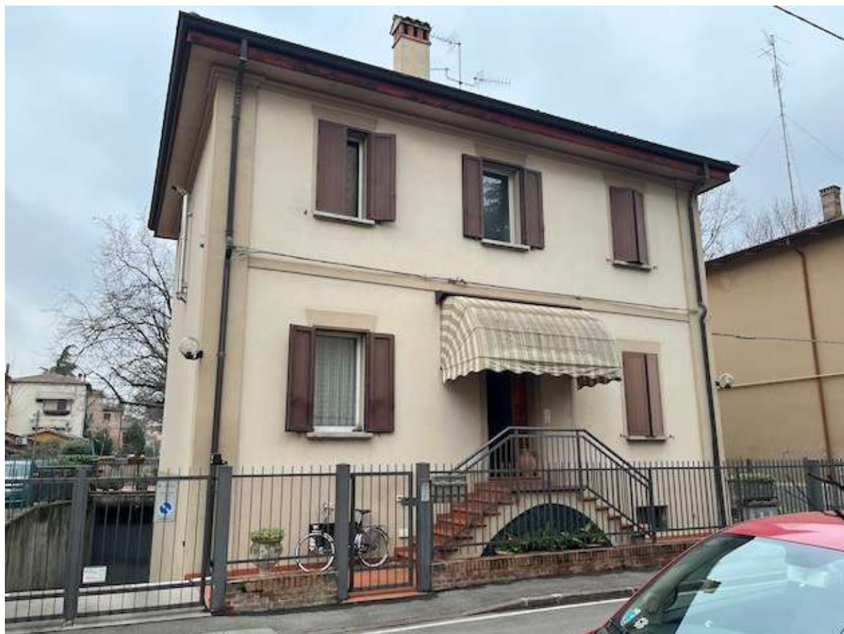
Lo stabile di cui l'immobile è parte – fronte strada
