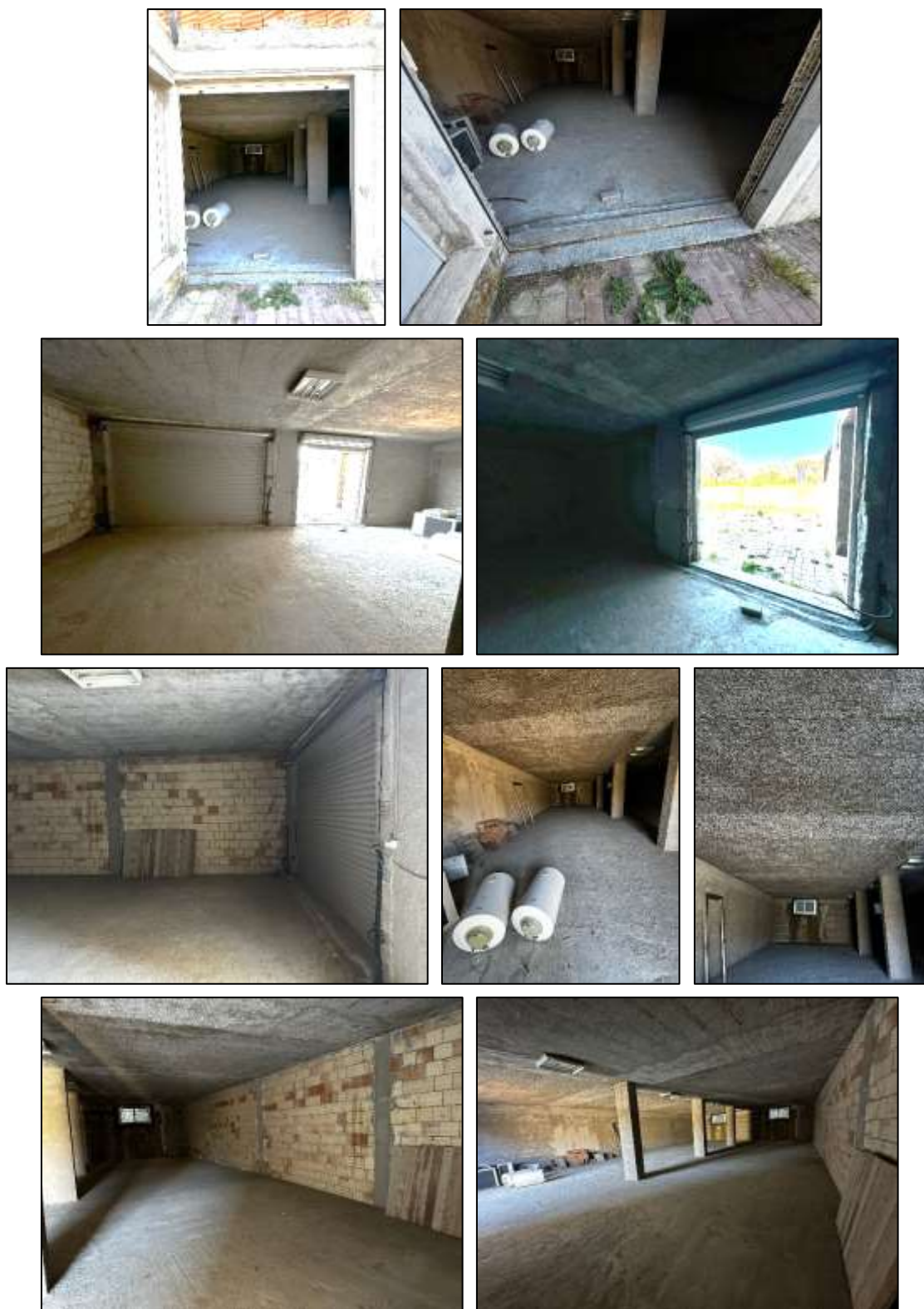
Figura 51– Interno BENE 5-6 - Foglio 8 – particella 1886 – subalterni 1-2 – PIANO SEMINTERRATO
