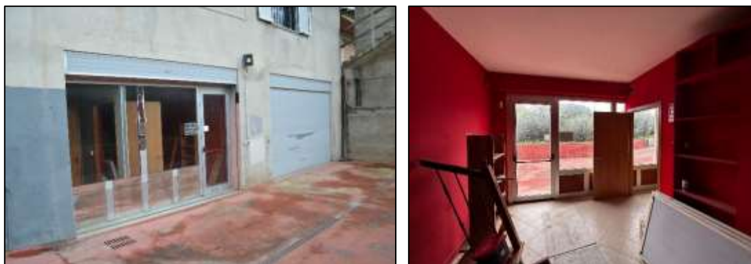
Figura 27 - Ingresso BENE 1 - piano seminterrato
