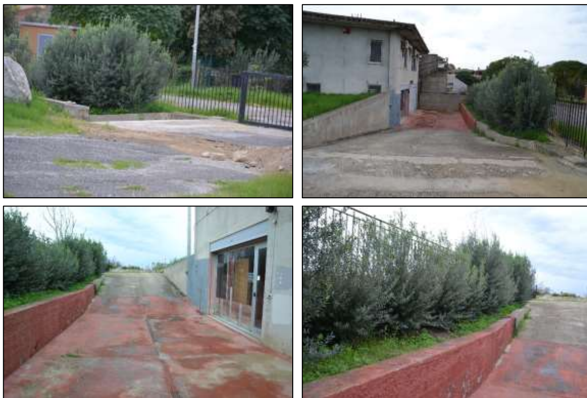
Figura 23 - Porzione subalterno 4 costituente rampa di accesso
