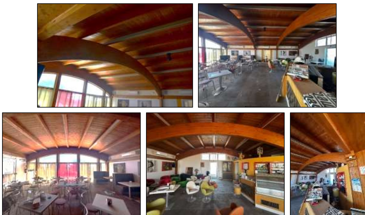
Figura 60 – Copertura a volta in legno lamellare
