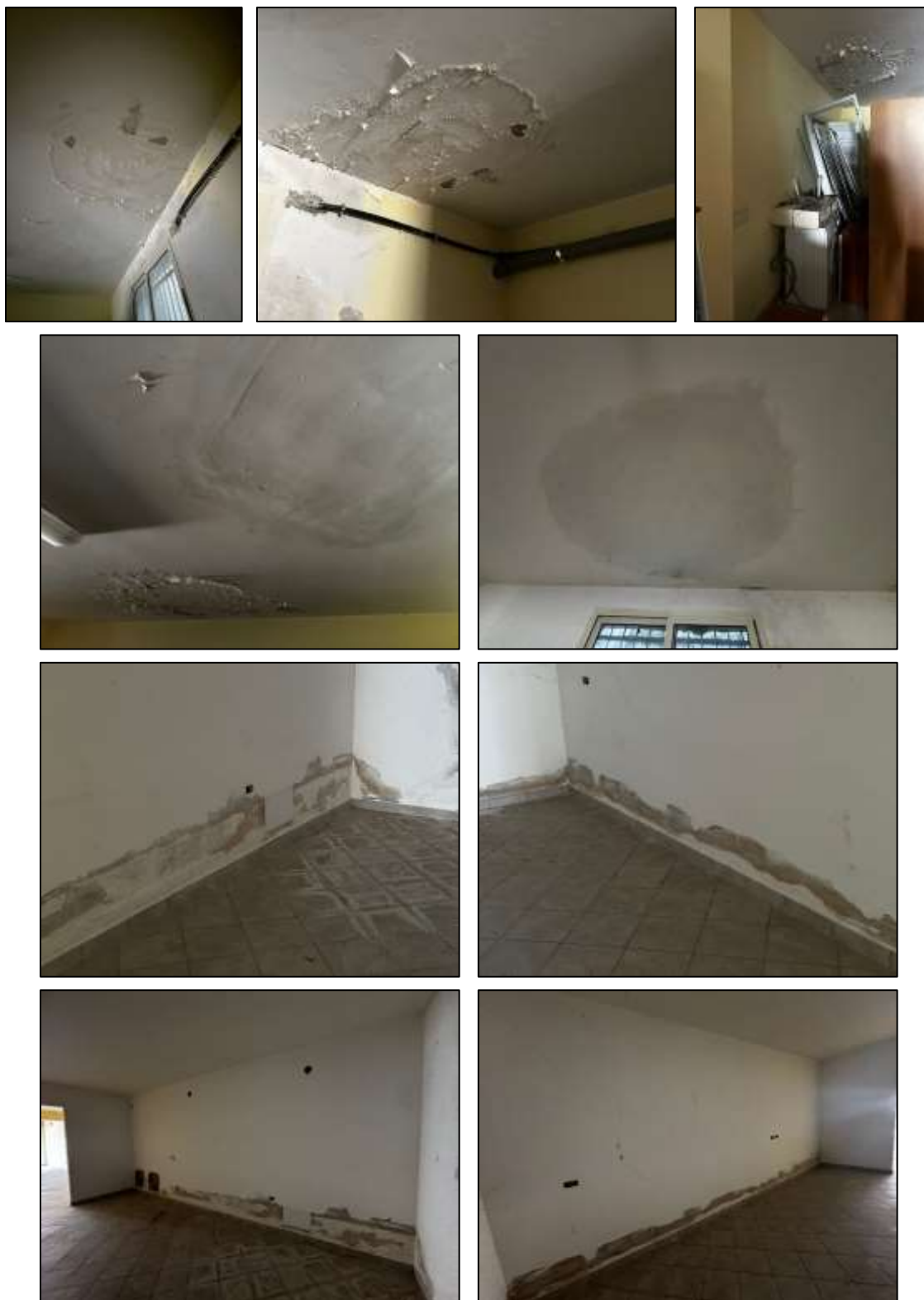
Figura 54 - Fenomeni infiltrativi in corrispondenza delle aperture
