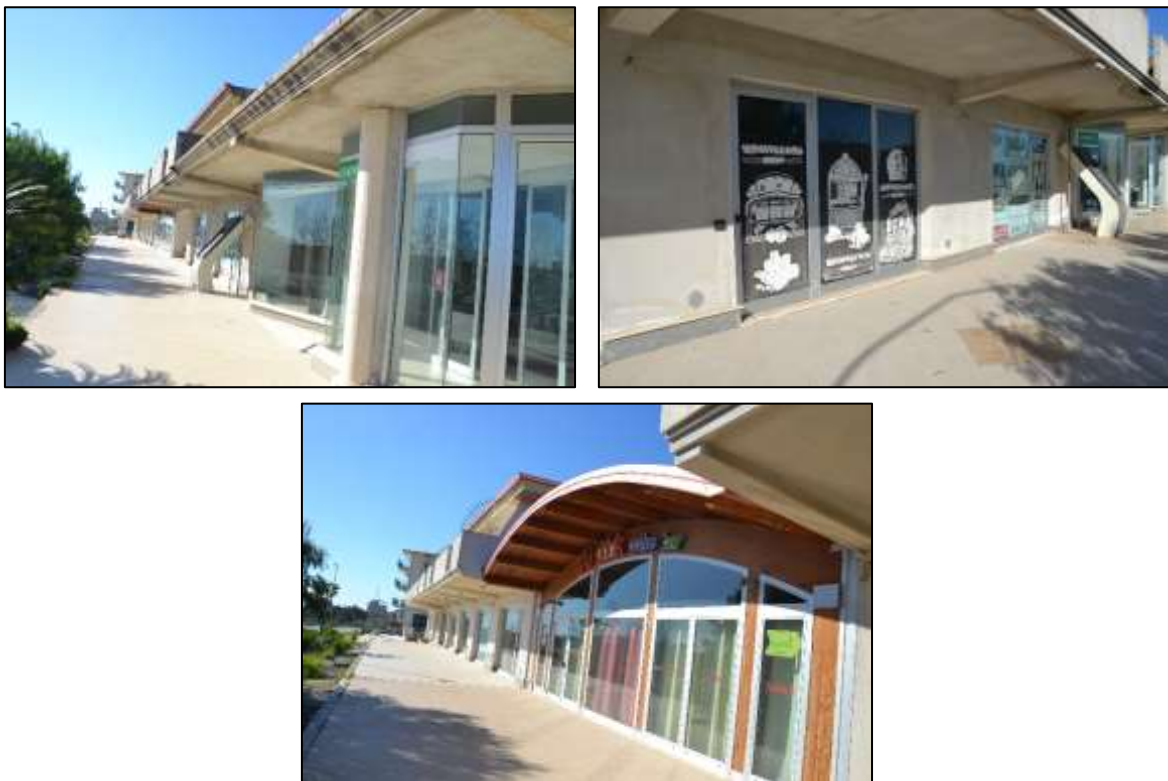
Figura 44 - Subalterno 6 (particella 1886) costituente area esterna piastrellata
