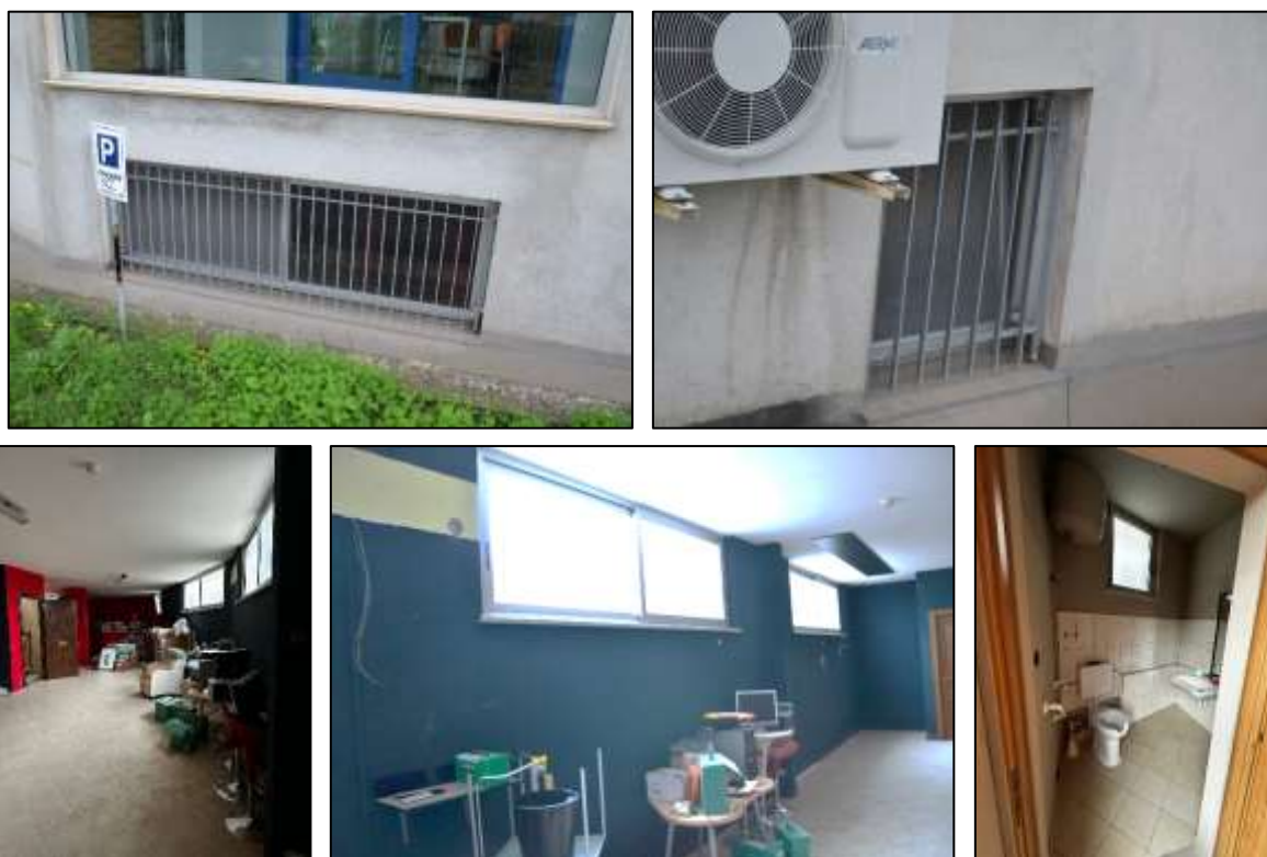
Figura 32 – Infissi esterni BENE 1 – Finestre piano seminterrato
