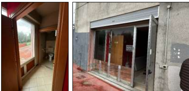
Figura 33 – Infissi esterni BENE 1 - Vetrate piano seminterrato
