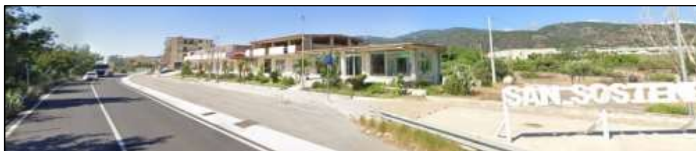
Figura 15 - Vista del complesso edilizio dalla SS106
