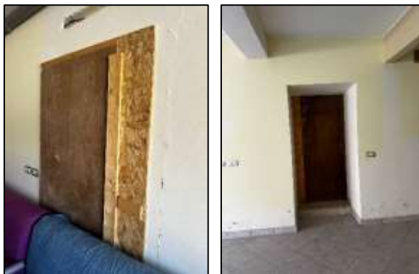
Figura 52 - Apertura di collegamento tra i due vani
