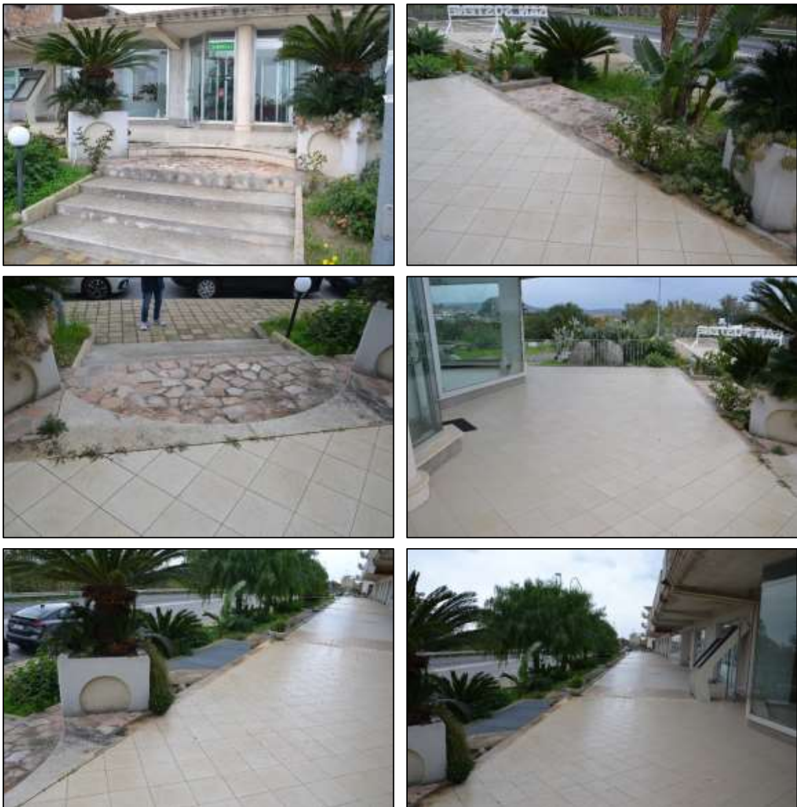
Figura 19 - Porzione subalterno 5 costituente area esterna piastrellata
