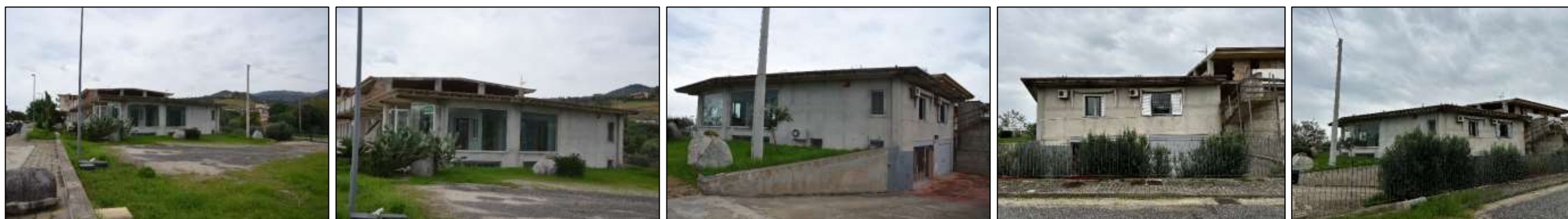
Figura 18 – Vista di insieme del fabbricato
