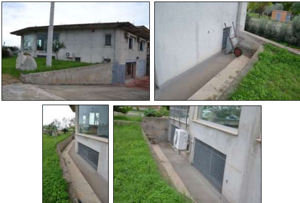
Figura 24 - Scannafosso che si sviluppa lungo il lato OVEST del fabbricato
