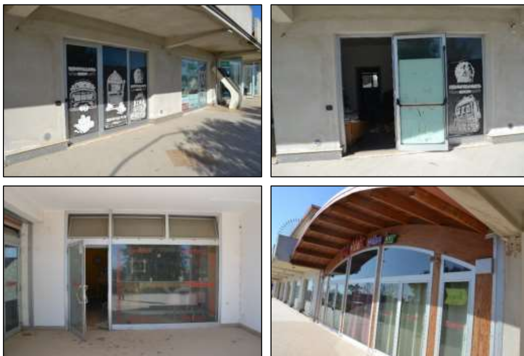
Figura 59 - Ingressi posti sul prospetto EST
