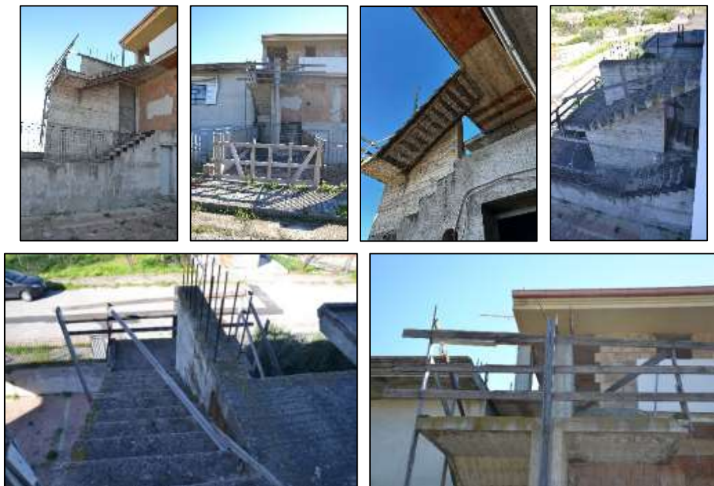
Figura 41 - Vano scala esterno
