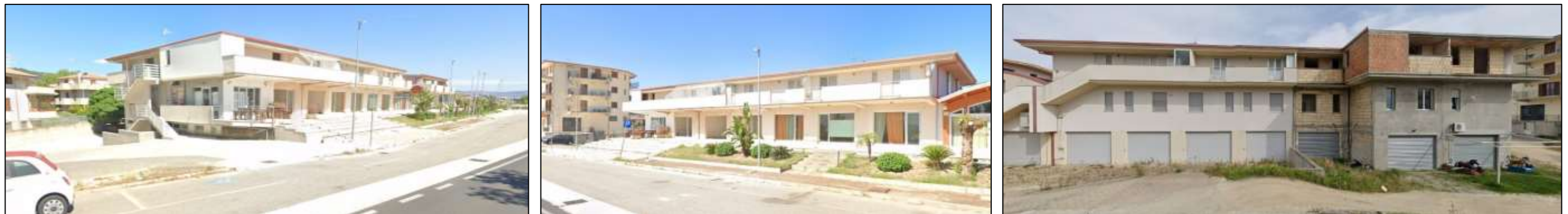
Figura 70 – Vista di insieme del fabbricato
