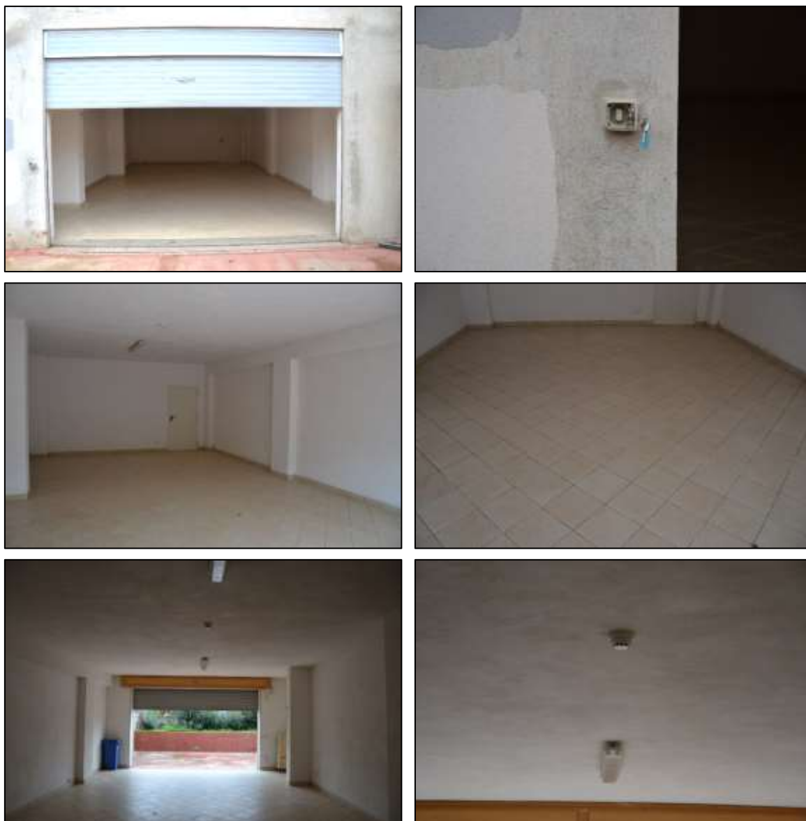
Figura 40 – BENE 3 - Foglio 8 – particella 1710 – subalterno 3 – PIANO SEMINTERRATO
