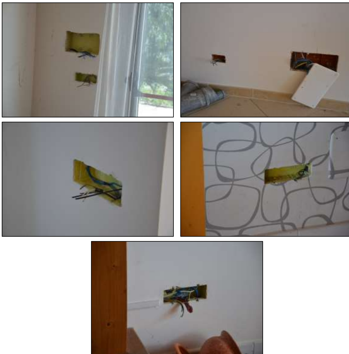
Figura 63 - Manomissione impianti
