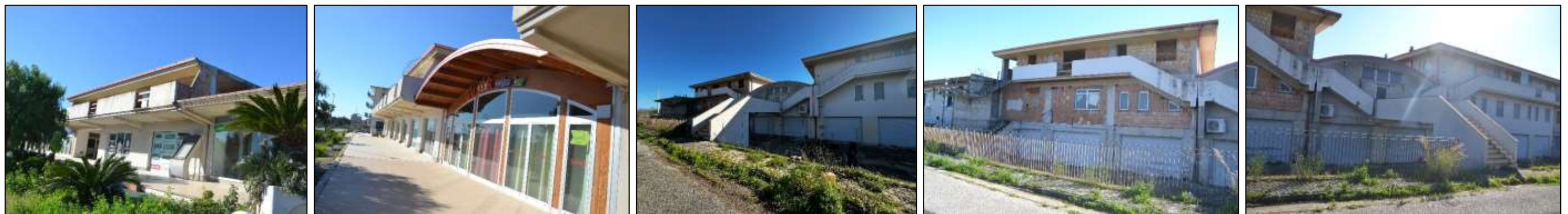
Figura 46 – Vista di insieme del fabbricato particelle 1886
