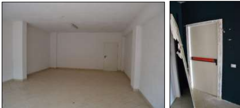
Figura 38 - Porta di collegamento tra subalterno 3 e subalterno 2
