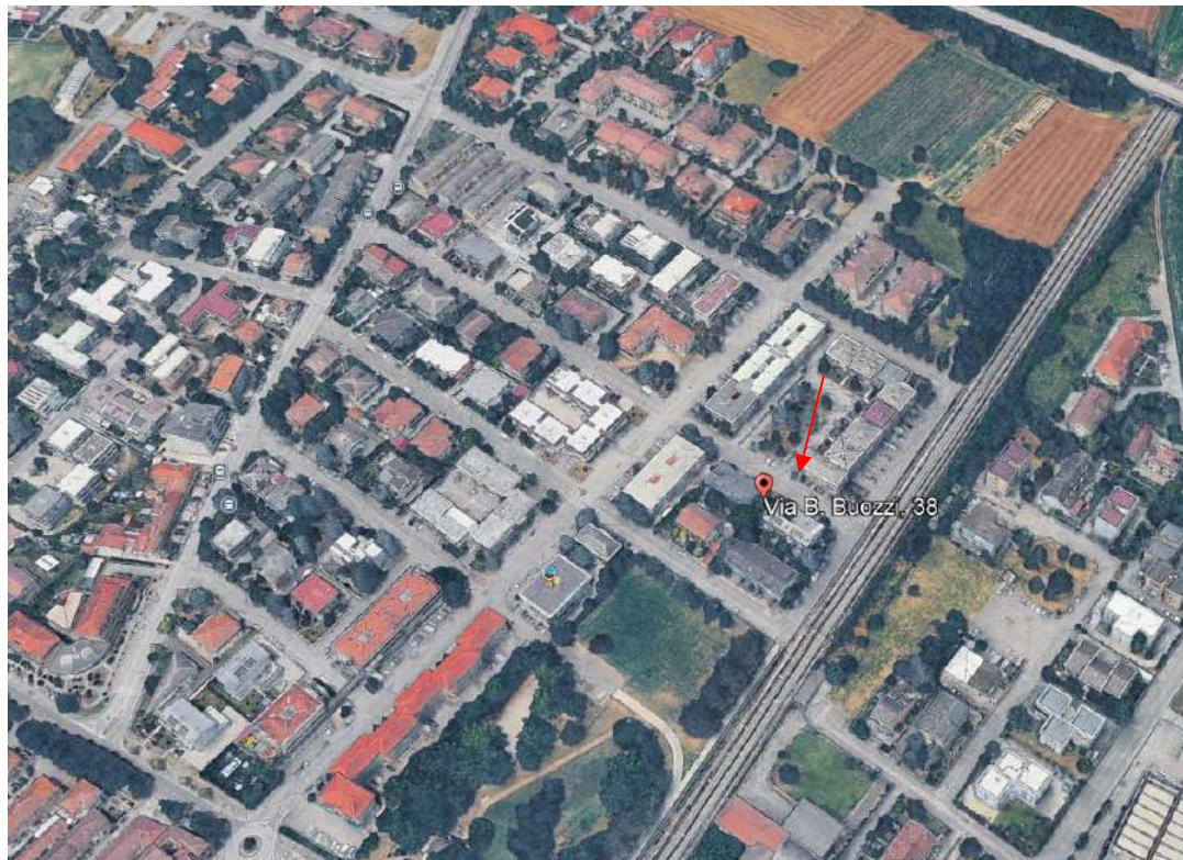
Vista aerea della zona e del contesto dove sorge IL fabbricato pignorato
