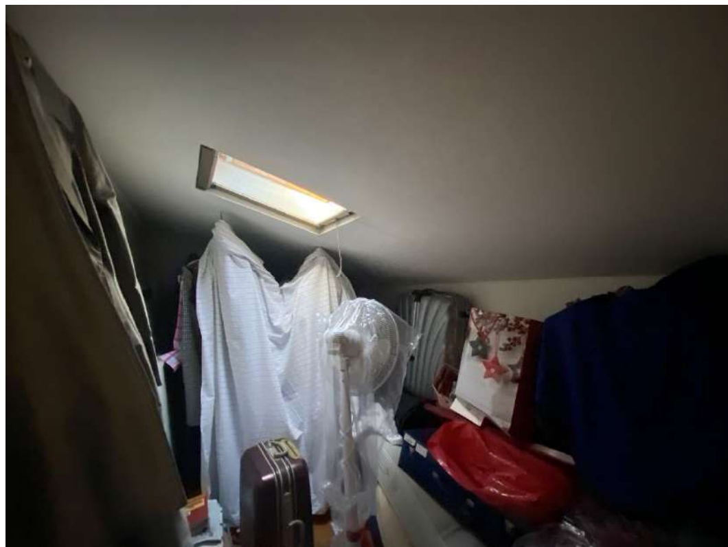
Vista dell'ambiente destinato a ripostiglio nel sottotetto
