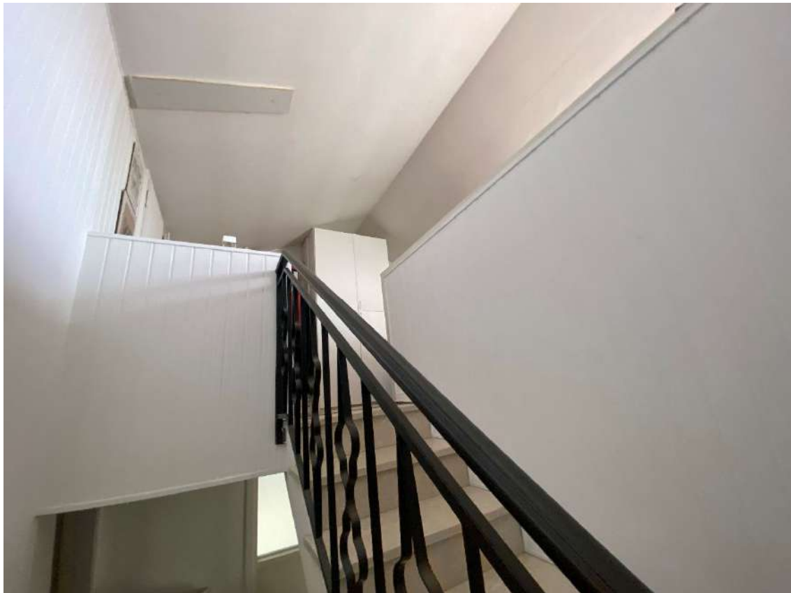
Vista dello sbarco della scala all'ultimo livello, sottotetto
