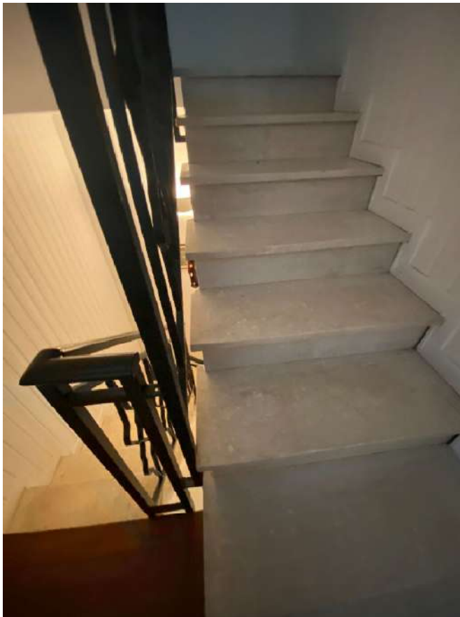
Vista della scala interna, ricoperta di marmo botticino, che conduce sia alla zona notte del piano primo che al garage e cantina al livello interrato
