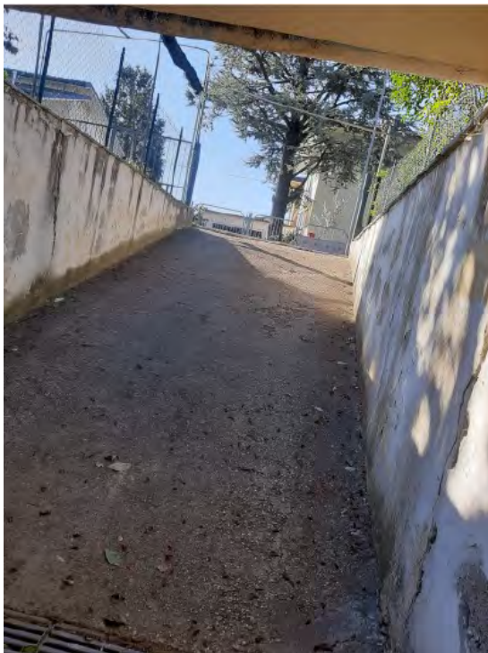
Rampa carrabile per l'accesso all'u.i. mapp. 1403/3 e interni
