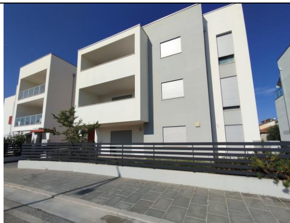
Fig. 10 - Edificio ricadente nel lotto n. 13 – F. 42 particella 1233
