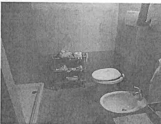
Piano Secondo: Bagno parz.te allo stato grezzo
